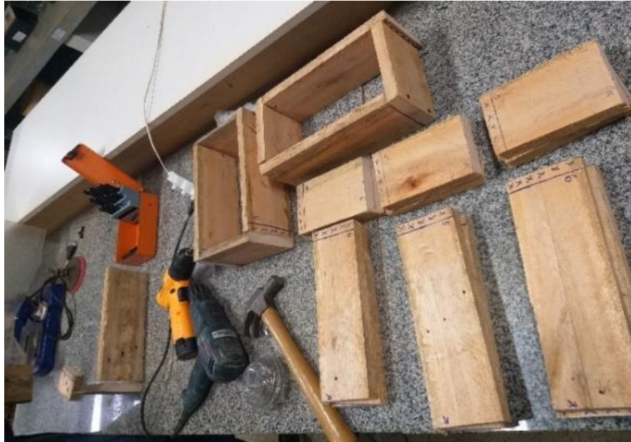
Figura 11 – Execução das formas em madeira
