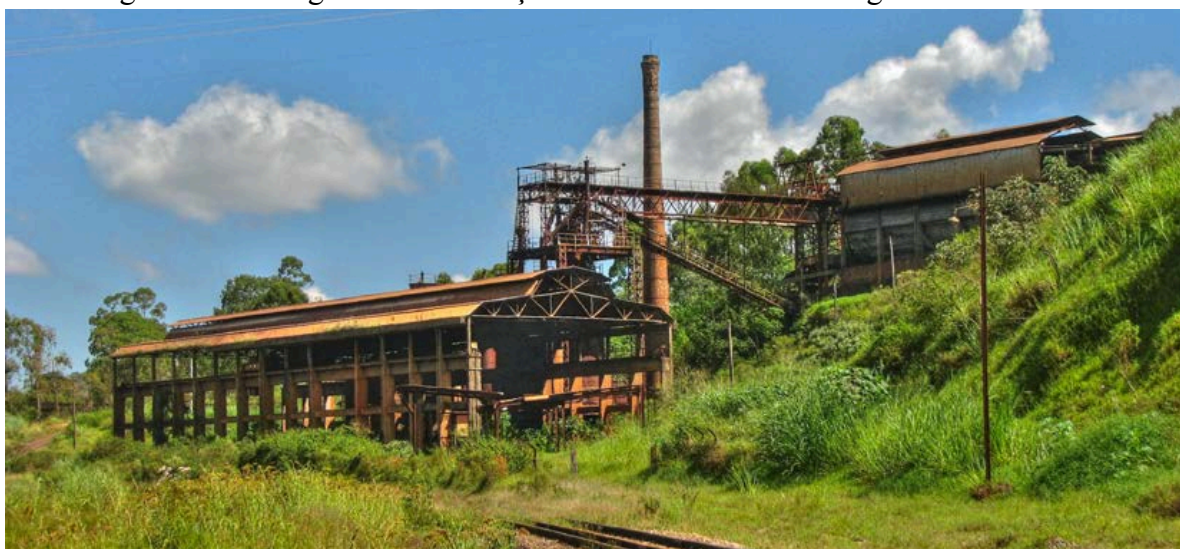
Figura 9 - Visão geral das instalações desativadas da Siderúrgica Barra Mansa.
