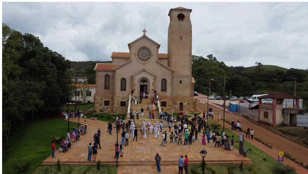
Figura 23 – Fachada principal da Igreja do sagrado Coração de Jesus depois de restaurada
