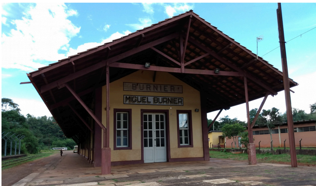
Figura 20 – Estação ferroviária de Miguel Burnier depois de restaurada
