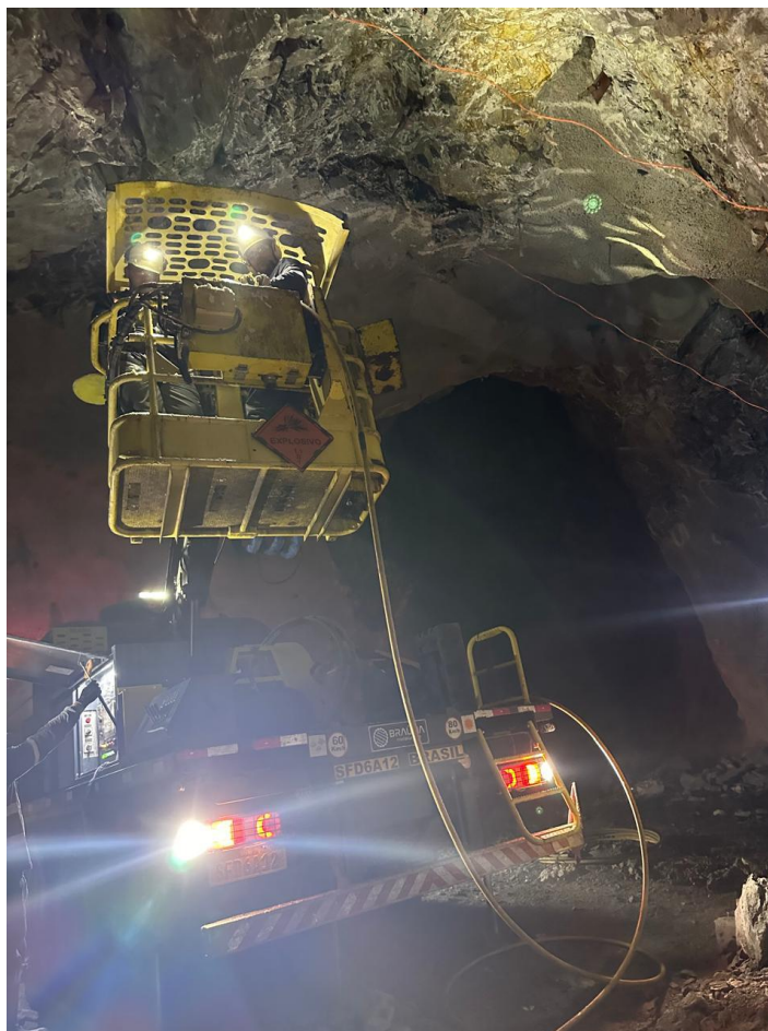
Figura 22. Plataforma de elevação contida no caminhão de emulsão. Fonte: Elaborado pelo autor.
