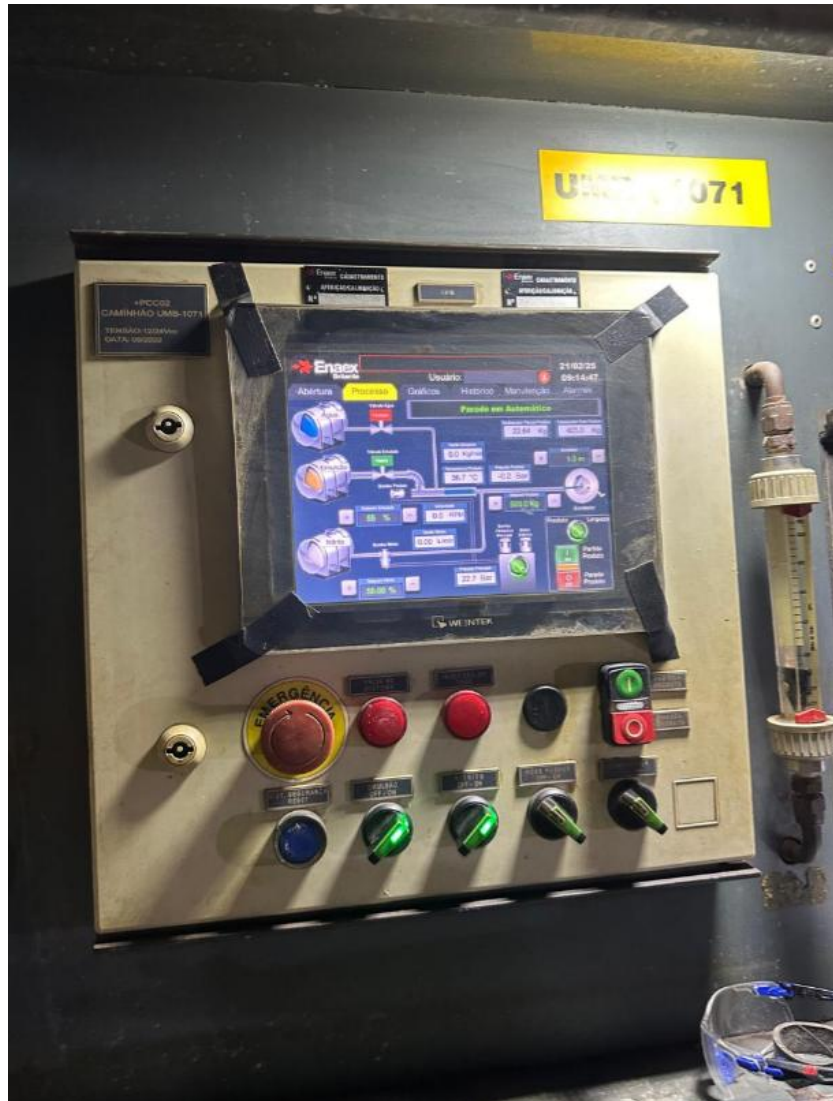
Figura 23. Painel de controle dos parâmetros da emulsão bombeada. Fonte: Elaborado pelo autor.
