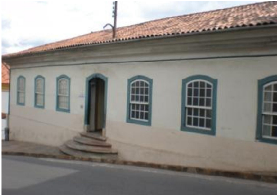
Figura 1 - Primeira locação da Escola de Minas em Ouro Preto, mar/2009.
