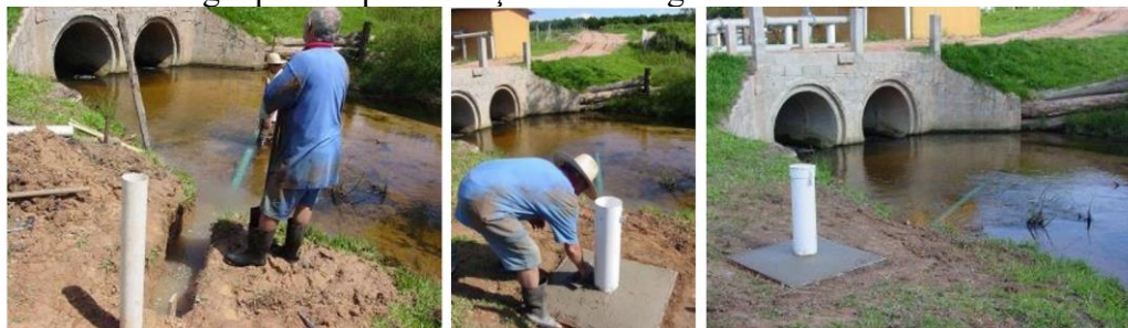
Figura 24 – Metodologia para implementação de limnógrafo em cálculo de vazão em bueiros
