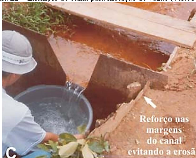
Figura 22 – Exemplo de calha para medição de vazão (vertedouro).
