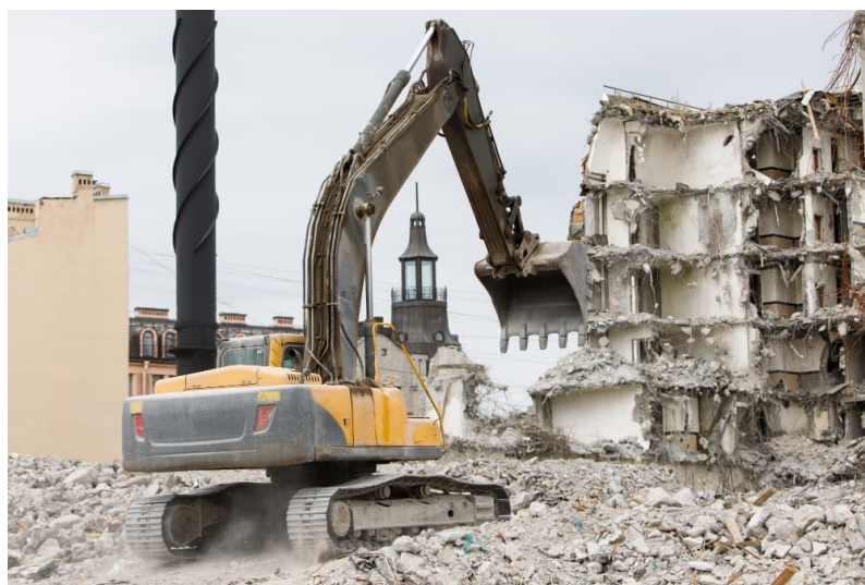
Figura 08: Demolição de prédio.
