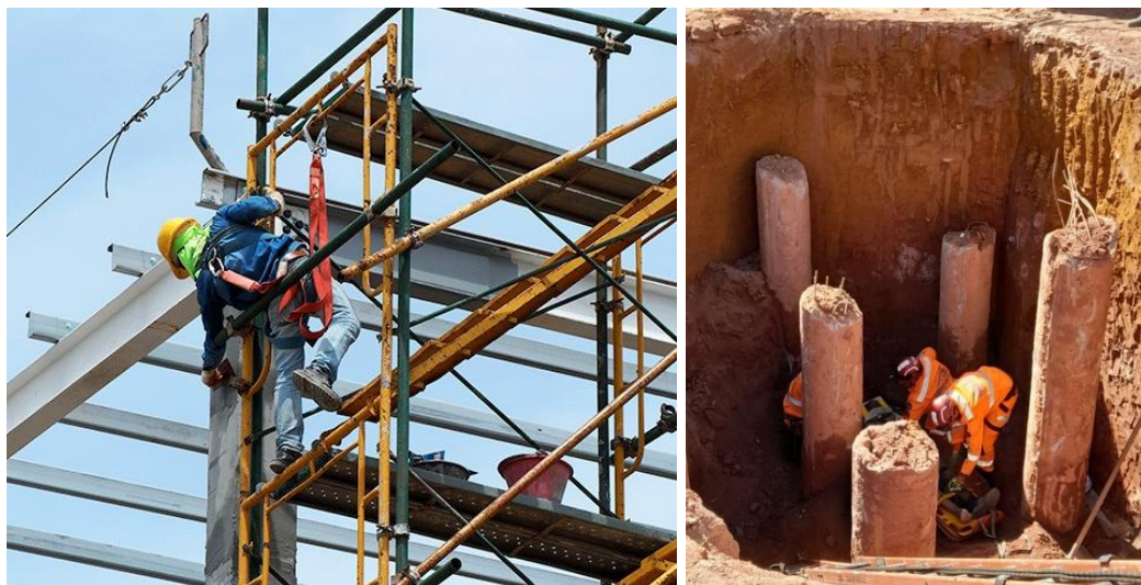
Figuras 12 e 13: Complexidade das tarefas desempenhadas na construção civil.
