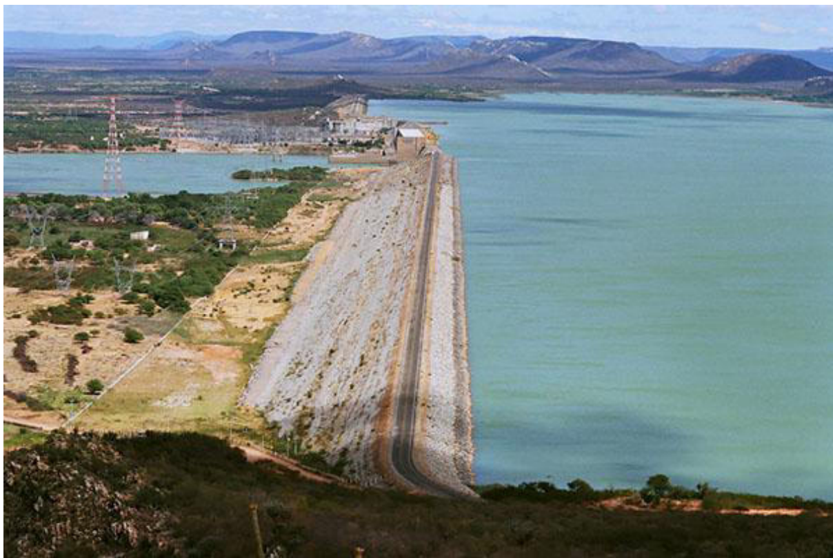
Figura 16 - Usina Hidrelétrica de Sobradinho. Fonte: Viva o Sertão (2014).
