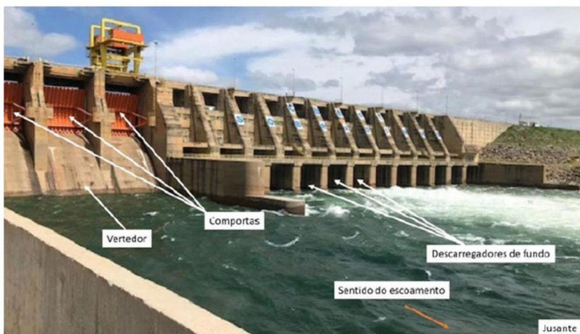
Figura 15 – Elementos da Usina Hidrelétrica de Sobradinho. Fonte: Pedrosa (2023).
