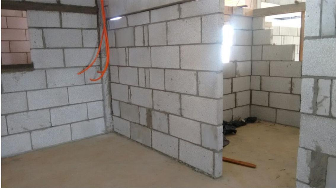
Figura 23: Blocos pré fabricados de concreto celular em construção civil brasileira (AVS, 2017).
