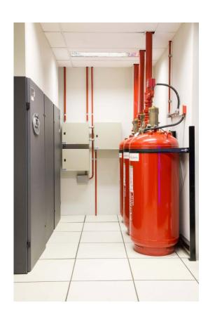
Figura 15 – Os tanques contém o gás FM-200
