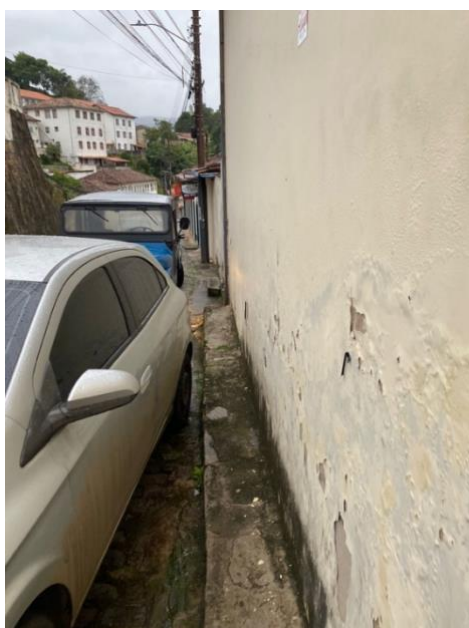
FIGURA 3 – PASSEIO ESTREITO EM OURO PRETO, MINAS GERAIS.
