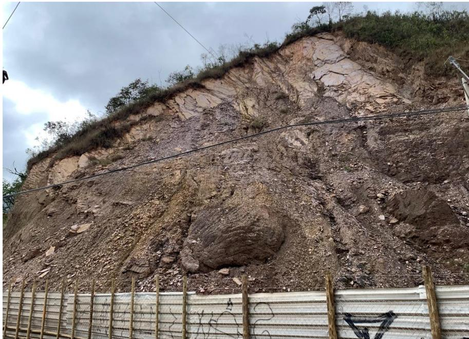
Figura 11 - Foliações expostas na porção superior da superfície deslizada, talude em estado atual.
