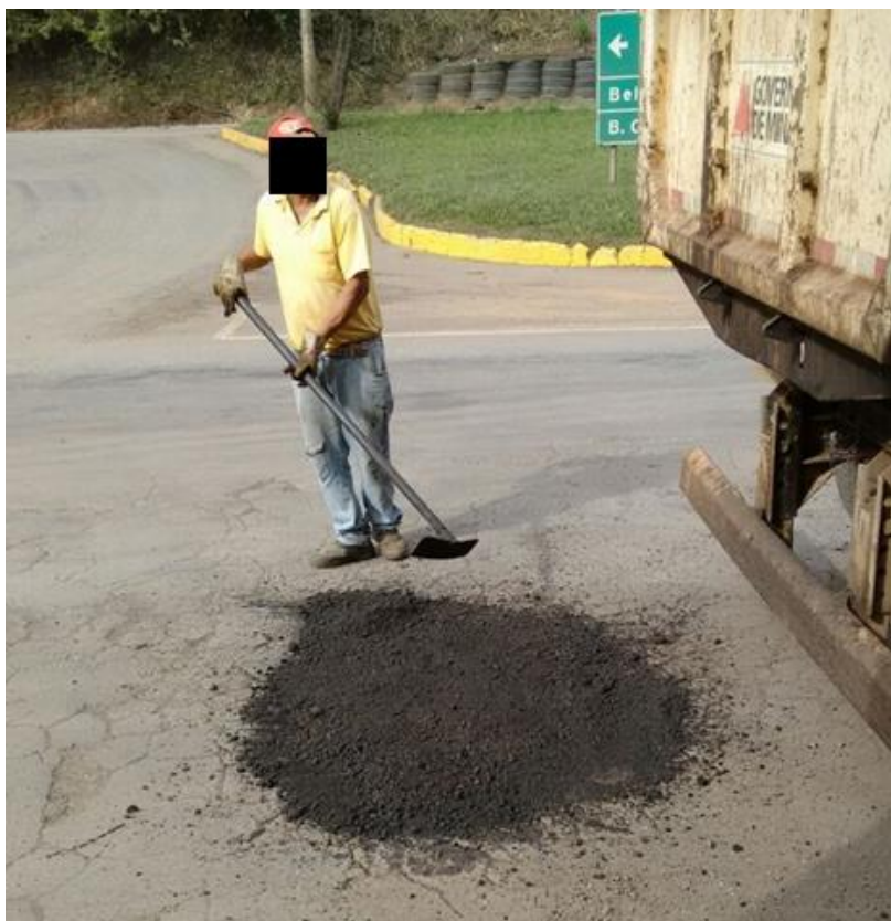
Figura 14: Aplicação do preparo asfáltico.
