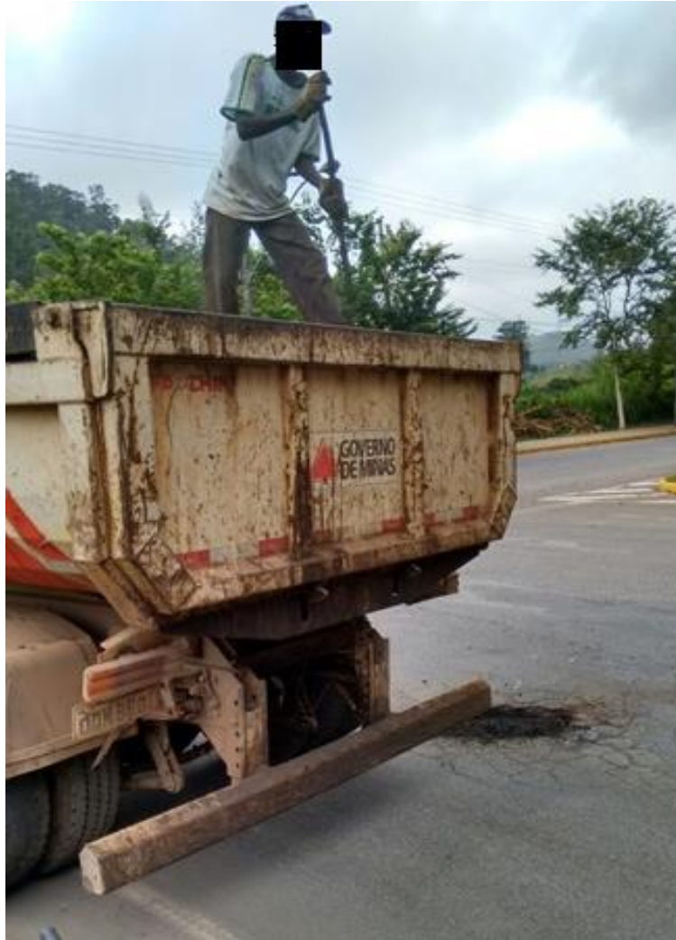
Figura 13: Retirada do preparo asfáltico do caminhão.
