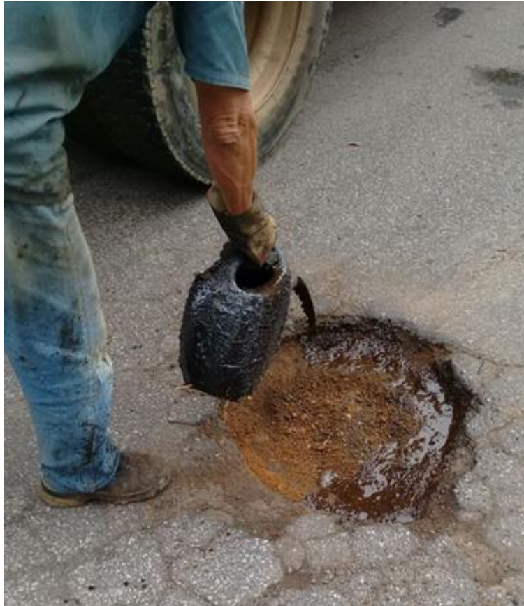
Figura 11: Processo de aplicação da emulsão.
