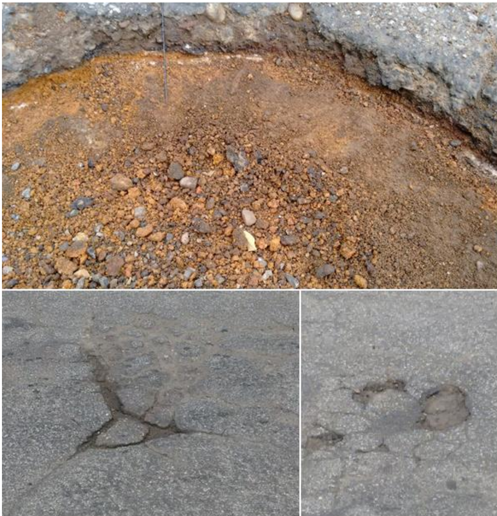
Figura 9: Problemas no asfalto que necessitam de reparo.
