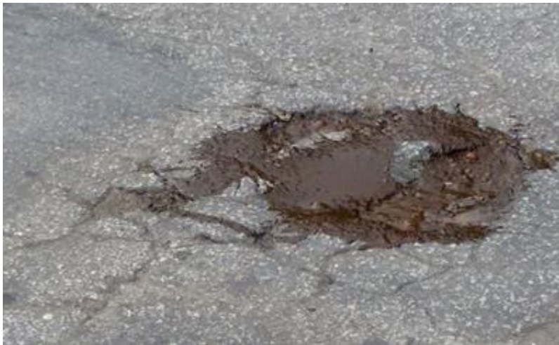
Figura 12: Buraco pós-aplicação da emulsão.
