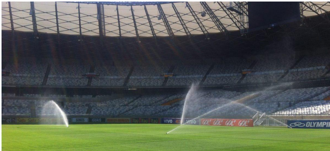
Figura 4 - Irrigação dos gramados do estádio Mineirão com a água coletada da chuva
