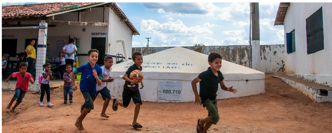
Figura 3 - Uma das mais de 7186 cisternas construídas através do Programa Cisterna nas Escolas na região do semiárido brasileiro
