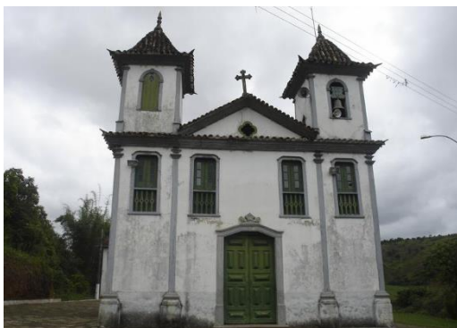
Figura 1: Fachada da Igreja Nossa Senhora da Conceição – Cachoeira do Brumado.
