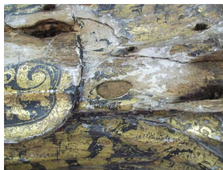
Figura 85: preenchimento da lacuna com massa de consolidação.
