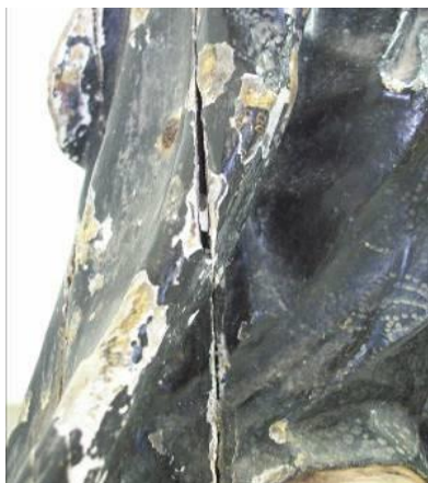
Figura 21: parte inferior do panejamento: descolamento dos blocos.
