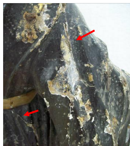
Figura 24: fissuras no escapulário e manga (parte posterior).
