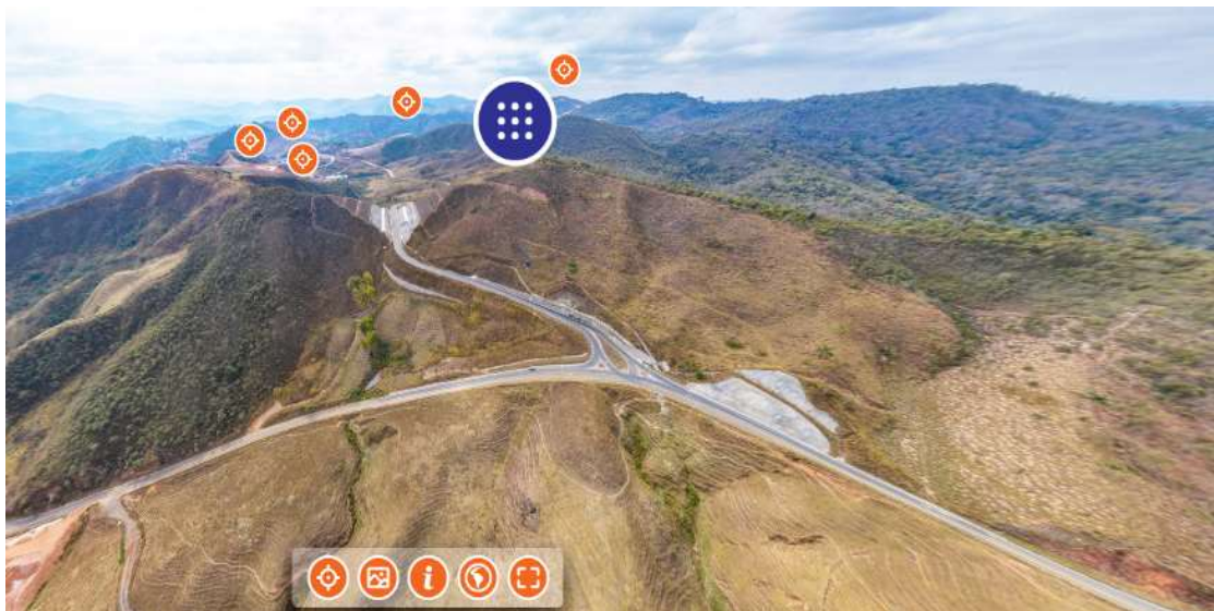
Figura 14 – Localização da trincheira – vista distante
