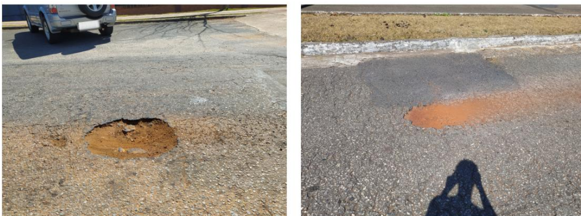
Figura 14 - Painelas no pavimento do campus Morro do Cruzeiro. Fonte: Acervo próprio.
