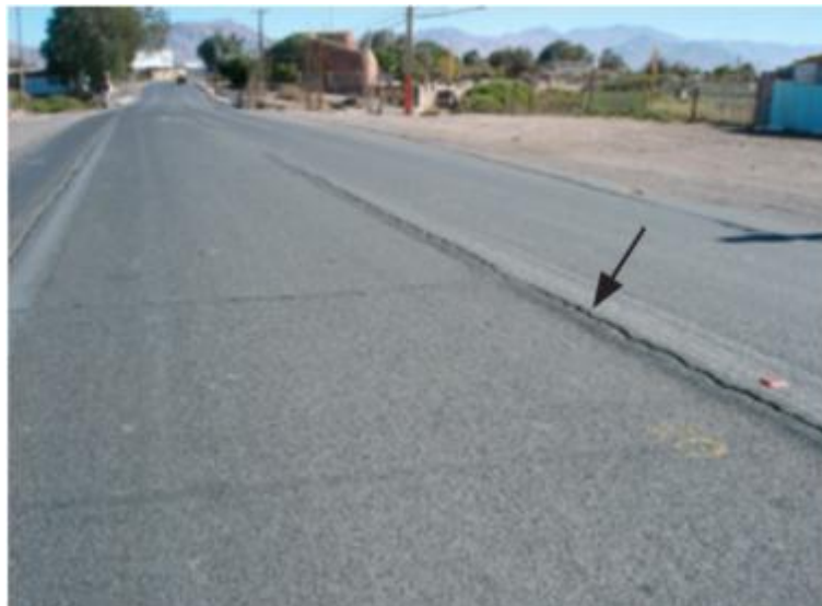
Figura 5 - Trinca de retração. Fonte: Bernucci et al. (2008).
