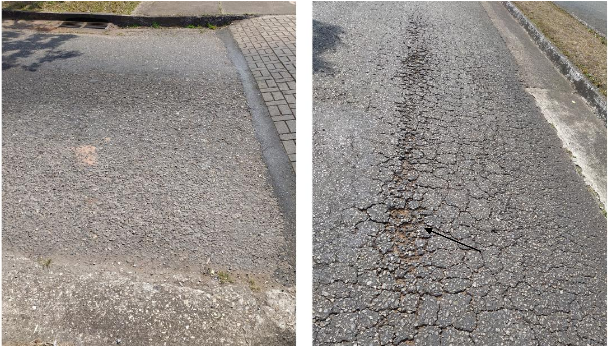
Figura 13 - Desgaste no pavimento do campus Morro do Cruzeiro. Fonte: Acervo próprio.
