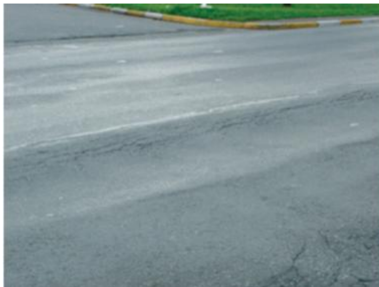
Figura 8 - Afundamento plástico de trilha de roda. Fonte: Bernucci et al. (2008).
