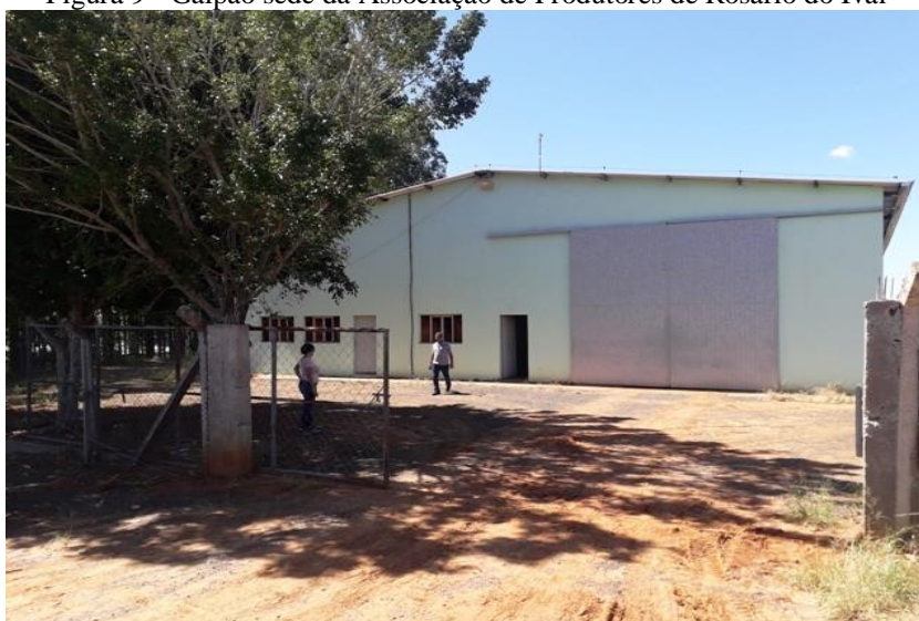
Figura 9 - Galpão sede da Associação de Produtores de Rosário do Ivaí
