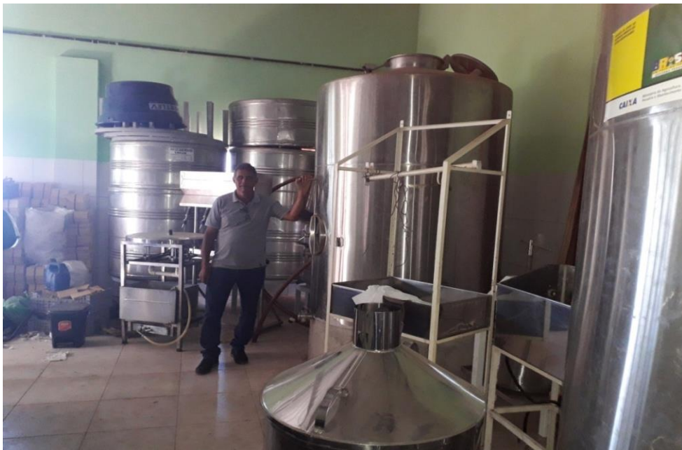
Figura 12 - Senhor Juvenal mostrando a fábrica e vinícola em fase de montagem, adquirida junto ao Governo Federal.
