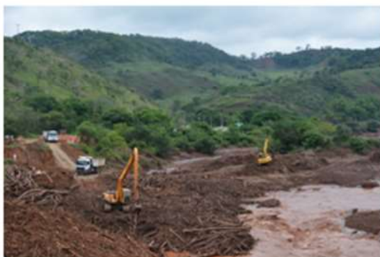
Detalhe dos tratores retirando os troncos das margens da represa Risoleta Neves.
