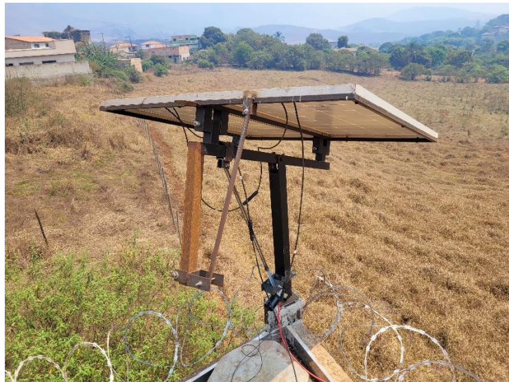
Figura 22: Painéis instalados no Seguidor solar
