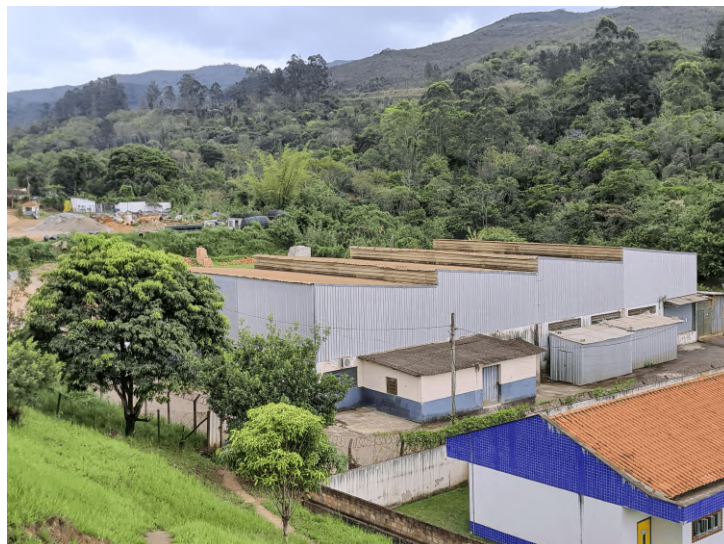
Figura 24 – Visão lateral do galpão
