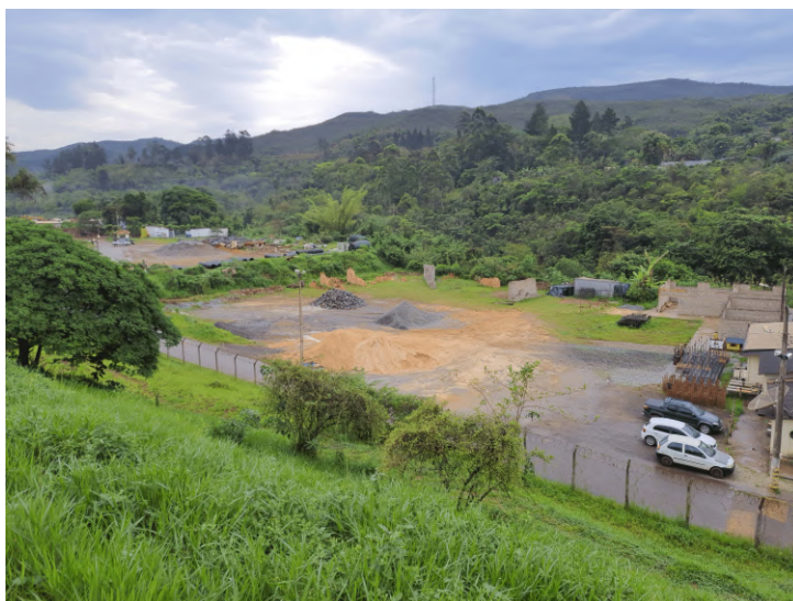
Figura 26 – Canteiro de obras
