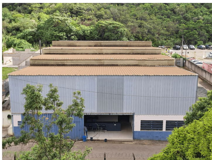
Figura 25 – Visão frontal do galpão
