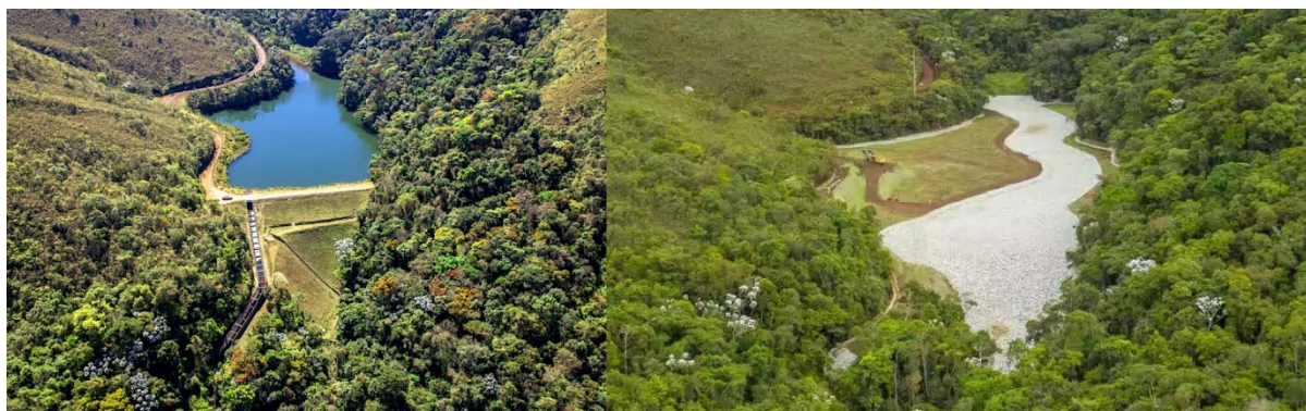
Figura 3 - Antes e depois da descaracterização da barragem 8B, em Nova Lima, região metropolitana de Belo Horizonte, Minas Gerais.
