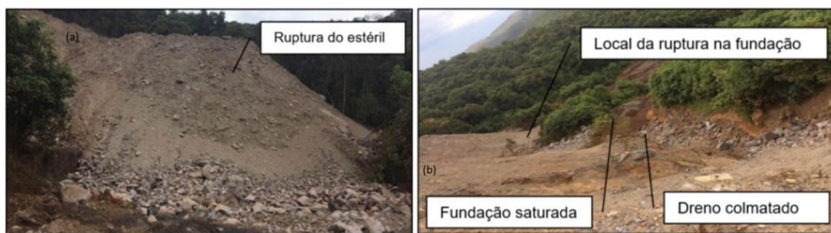
Figura 36 – À esquerda, a ruptura na pilha de estéril; à direita, a vista geral do vale.
