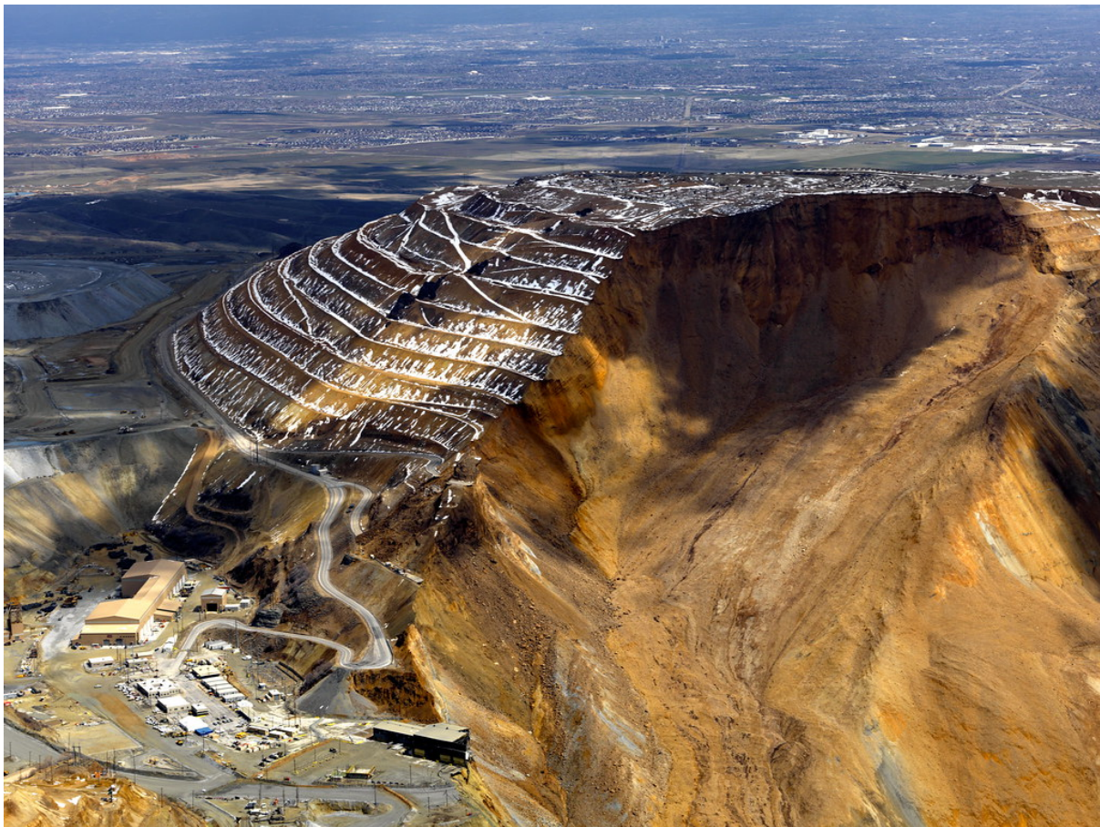
Figura 1 - Ruptura em taludes na mina a céu aberto Bingham Canyon Mine, nos EUA
