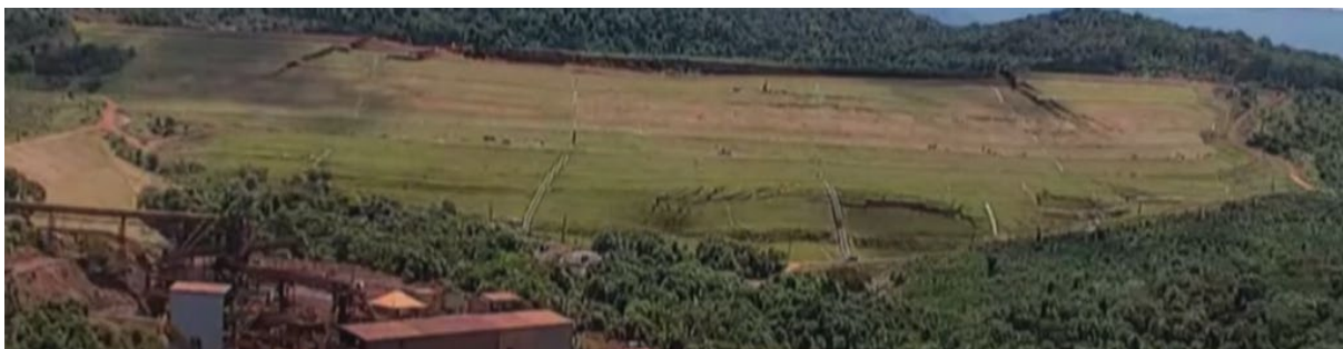
Figura 34 - Ruptura da Barragem B-I Da mina do Córrego do Feijão.
