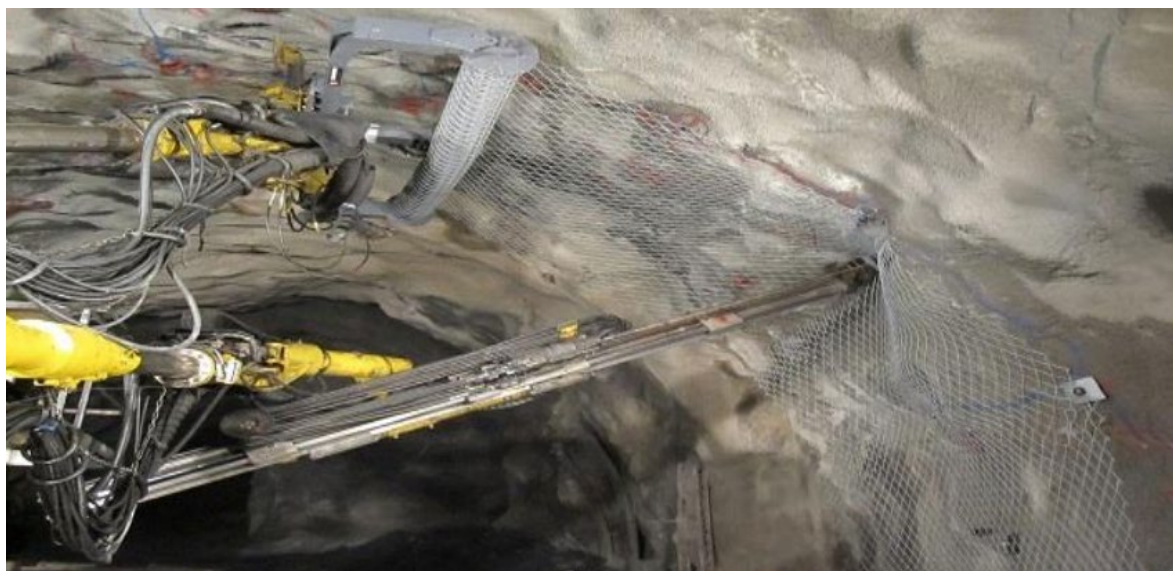
Figura 13 - Aplicação automatizada de tela em maciço escavado, junto com ancoragens e camada de concreto projetado.
