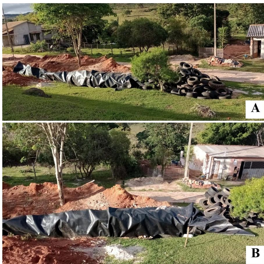
**Figura 7.8:** Construção de TEvap. A – Destaque para pneus utilizados na estruturação. B – Destaque para manta impermeável utilizada no local.
