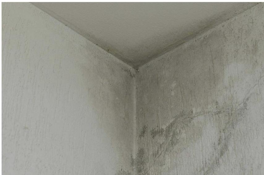
**Figura 15 - Paredes e tetos danificados devido à falta de impermeabilização**
