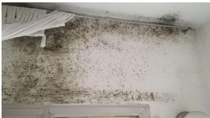
**Figura 18 - Parede localizada em um banheiro mofada devido a condensação de água**
