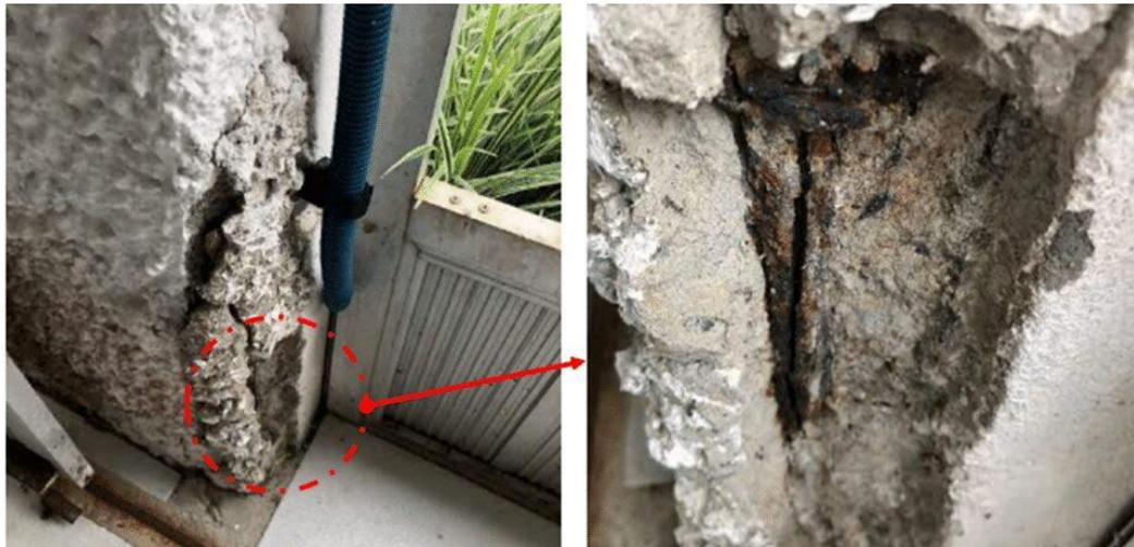
**Figura 10 - Desagregação e fissura por corrosão na base de um pilar (Imagem: Thórus Engenharia/Reprodução)**
