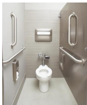
Figura 5 - Banheiro com barras de apoio
