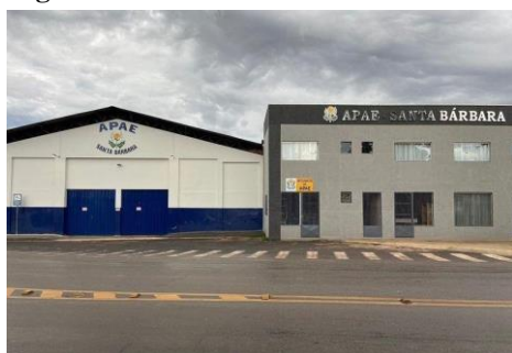
Figura 35 - Fachadas dos Blocos I e II
