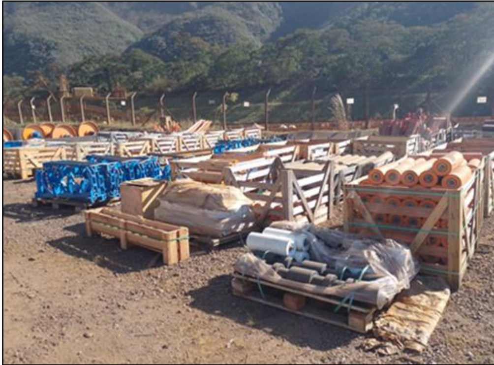
Figura 7 – Após a segregação
