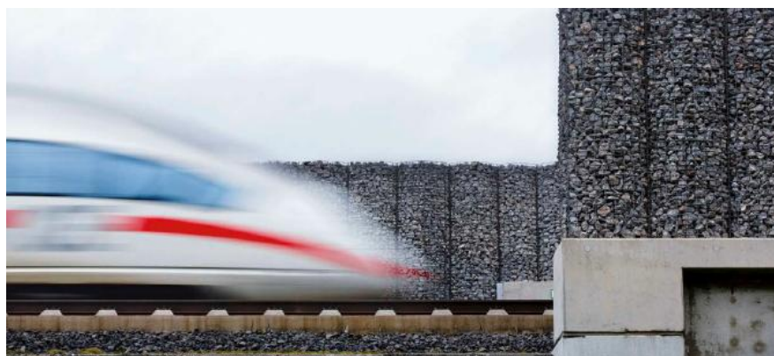
Figura 15 - Barreira acústica de gabião. (Fonte: DB AG)
