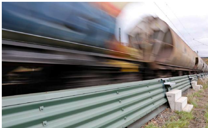
Figura 14 - Barreira acústica baixa. (Fonte: DB AG)
