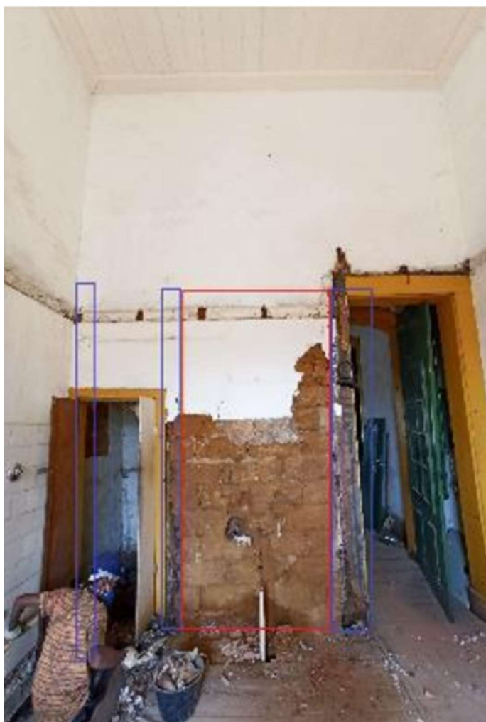
Figura 32 - Representação de estrutura de esteios.
