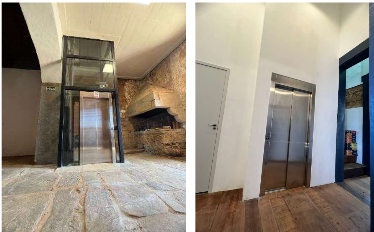
Figura 42 – Elevador após conclusão. Térreo (esquerda) e segundo andar (direita).
