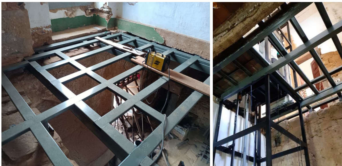
Figura 41 - Estrutura metálica para piso dos sanitários (esquerda) e caixa corrida do elevador (direita).
