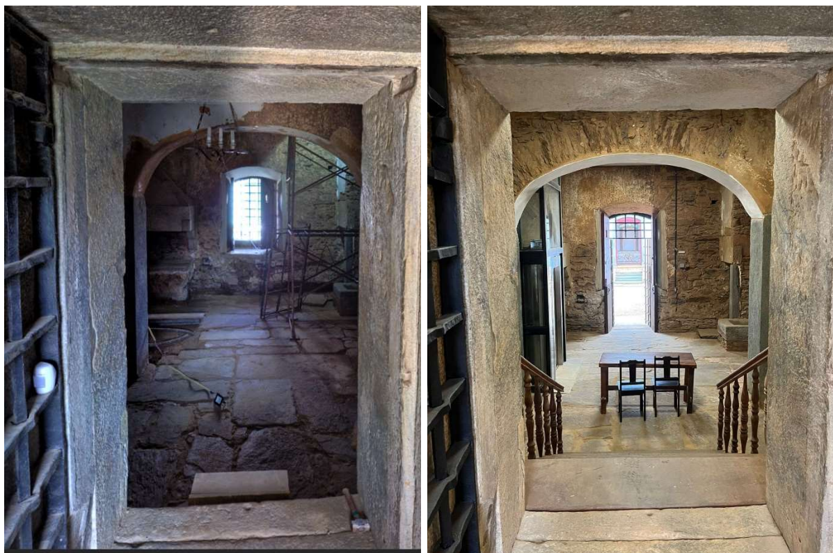
Figura 43 - Antes (esquerda) e depois (direita) da abertura da porta
