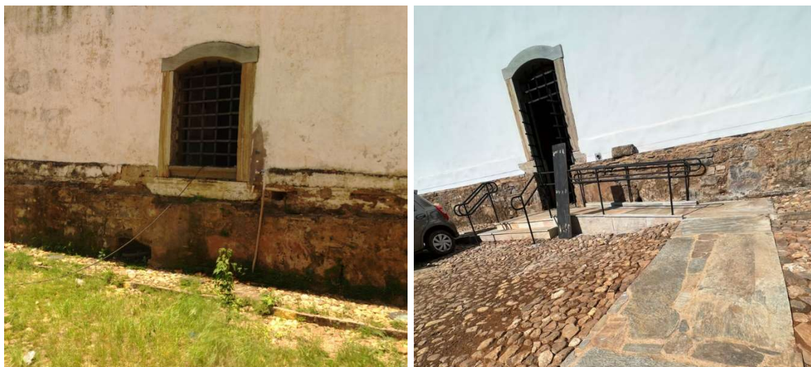
Figura 48 - Antes (esquerda) e depois (direita) da implantação da rampa acessível.
