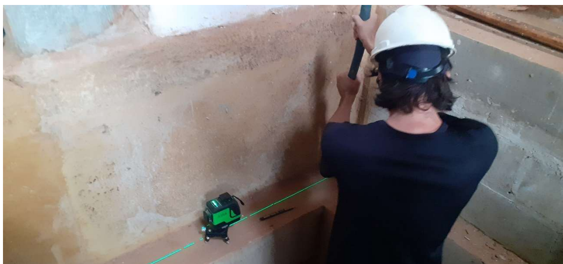
Figura 39 - Locação de pontos de ancoragem da caixa corrida do elevador
