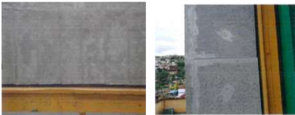
Figura 17 - Acabamento em pedra sabão serrada
