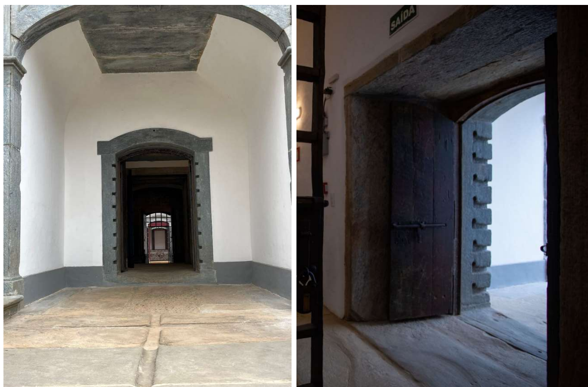
Figura 45 - Porta P1 com ranhuras que podem ter sido utilizadas para retirar a grades
