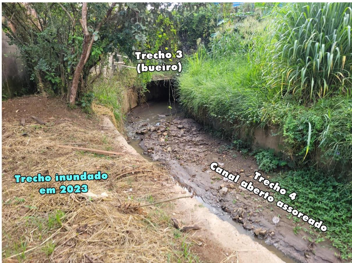
**Figura 17 - Canal assoreado do Trecho 4 com bueiro ao fundo (Trecho 3)**
