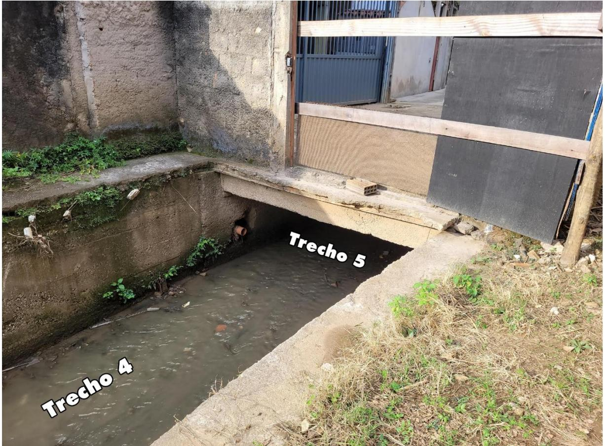
**Figura 16 - Canal aberto (Trecho 4) com emboque do canal fechado (Trecho 5)**
