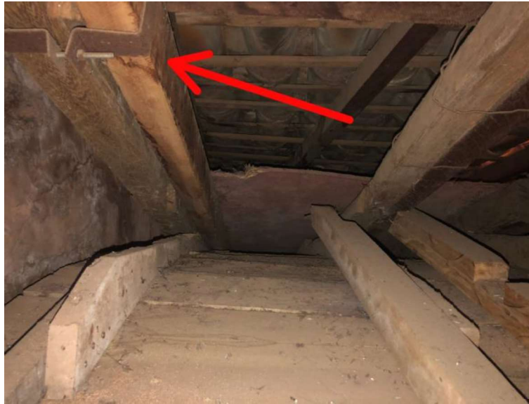
Figura 56 – Visão lateral das tesouras, onde é possível observar componentes metálicos unindo as antigas e as novas tesouras.
