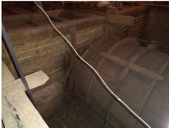
Figura 40 – Estruturas das paredes, em pau-a-pique, e do forro, em madeira, do altar da igreja.
