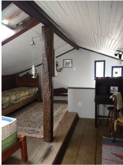
Figura 53 – Visão da parte interna de uma residência, onde é possível observar a ausência de tesouras, nesses casos, as paredes e pilares sustentam o telhado. Residência particular, Ouro Preto.
