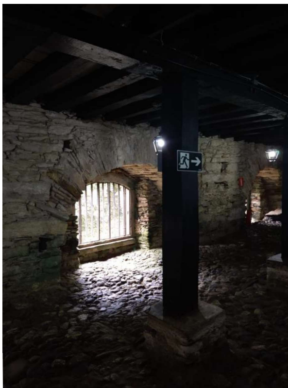
Figura 1 – Alicerces construídos com pedras empilhadas, Casa dos Contos.
