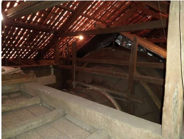
Figura 38 – Tesoura posicionada sobre o altar da igreja e parte superior do forro.
