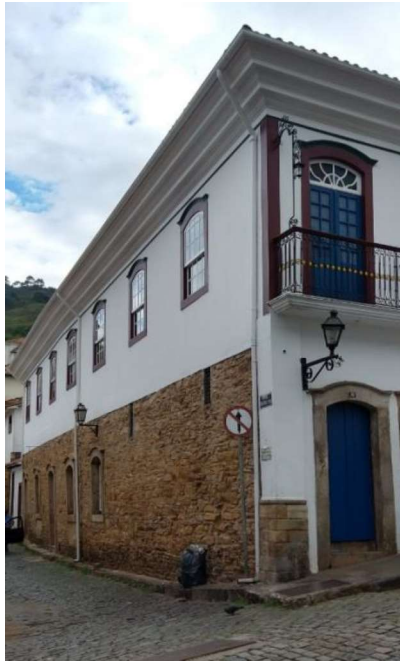
Figura 2 – Vista externa de parede em alvenaria de pedra. Rua conde de Bobadela, Ouro Preto.
