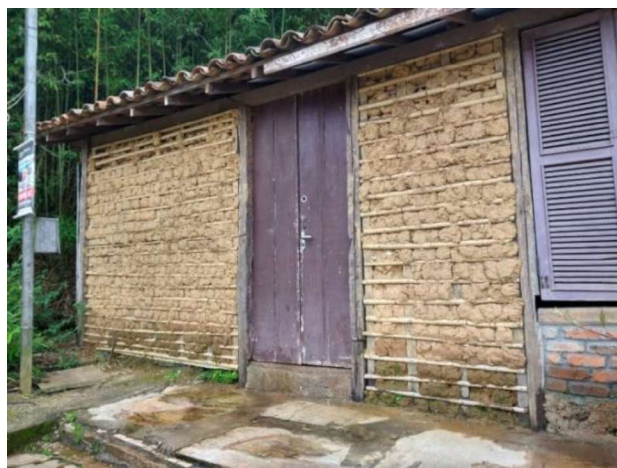
Figura 4 – Casa construída em pau-a-pique. Rua Padre Rolim, Ouro Preto.
