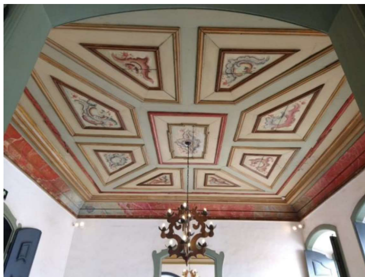
Figura 20 – Forro adornado, presente no segundo pavimento da Casa dos Contos, destacando também a presença de cimalhas internas.
