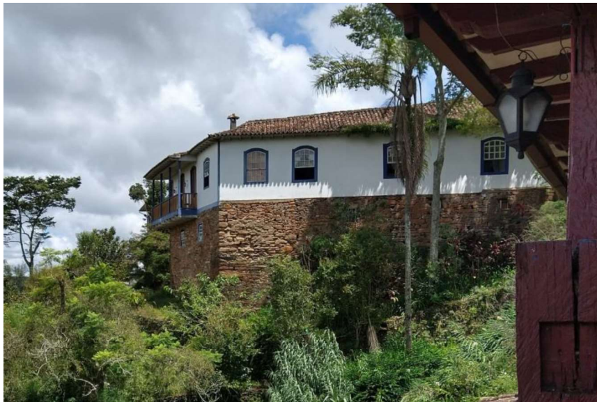
Figura 43 – Visão das fachadas posteriores da casa, com alicerces de pedras com altura que evidenciam a diferença de nível da casa em relação ao terreno.
