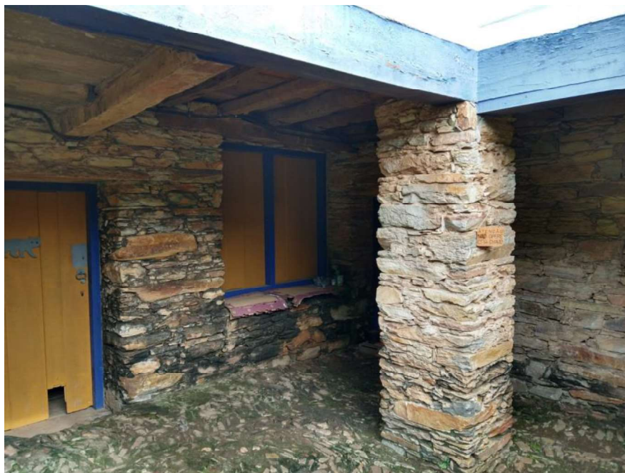
Figura 44 – Alicerces da casa, evidenciando que pedras de diferentes dimensões foram utilizadas.
