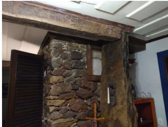
Figura 3 – Vista interna de parede em alvenaria de pedra. Residência particular, Bairro Rosário, Ouro Preto.
