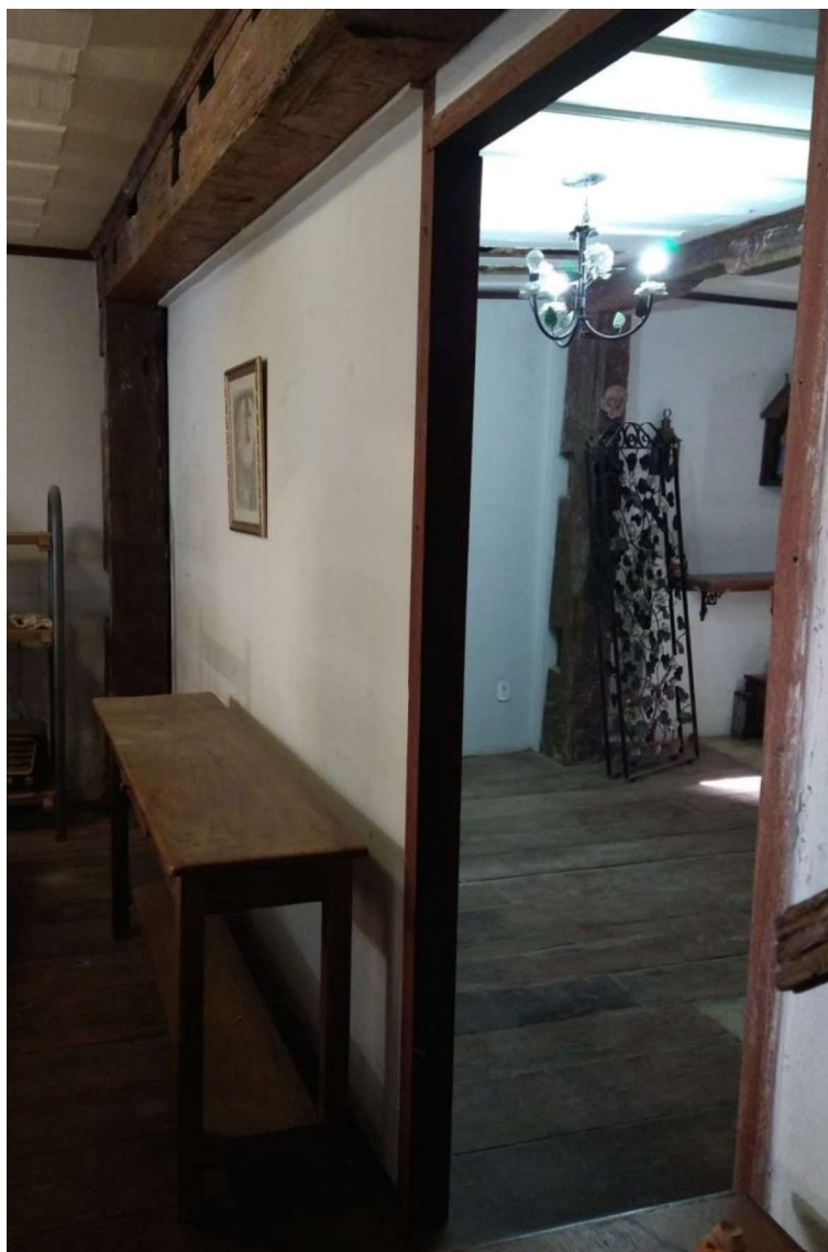
Figura 6 – Parede interna construída em tabique.
