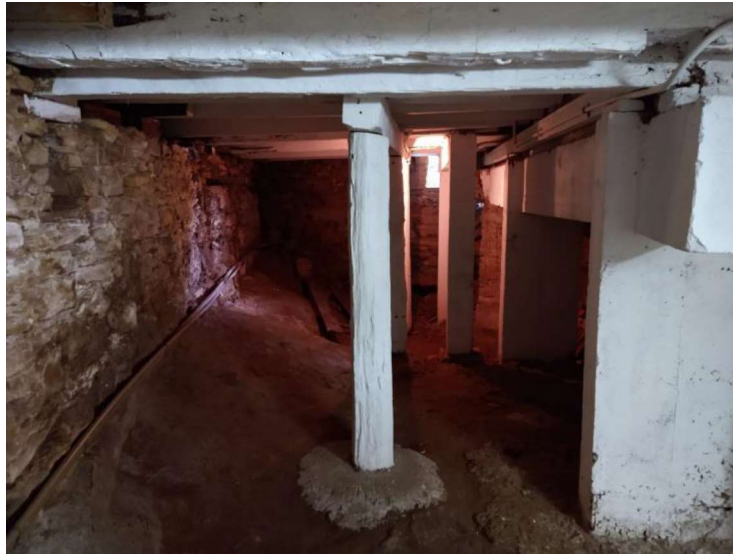
Figura 47 – Reforços em concreto e madeira na base da casa.
