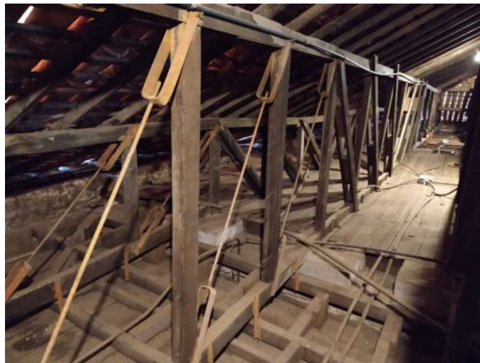
Figura 27 – Hastes metálicas usadas para impedir uma eventual movimentação lateral, distribuídas ao longo de toda a estrutura.
