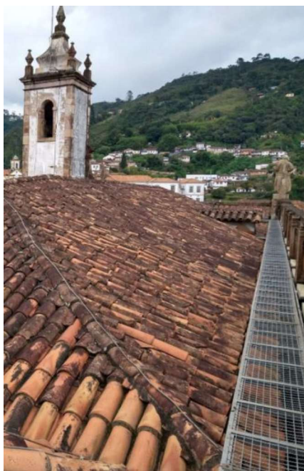
Figura 18 – Visão da parte superior da platibanda do Museu da Inconfidência.
