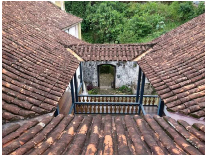
Figura 23 – Visão dos telhados acima da varanda.
