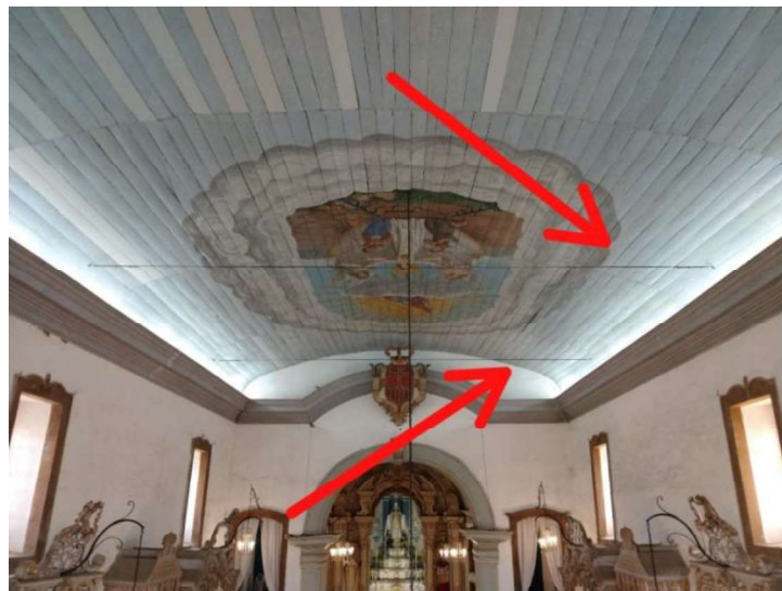
Figura 41 – Cabos de aço utilizados para impedir movimentação das tesouras passando sob o forro, indo de uma lateral a outra das paredes da igreja.
