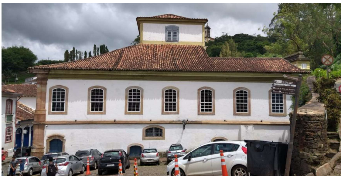
Figura 21 – Visão lateral da Casa dos Contos, Ouro Preto.
