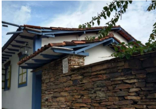
Figura 15 – Telhados com estrutura do contrafeito em evidência. Rua Conselheiro Quintiliano, Ouro Preto.
