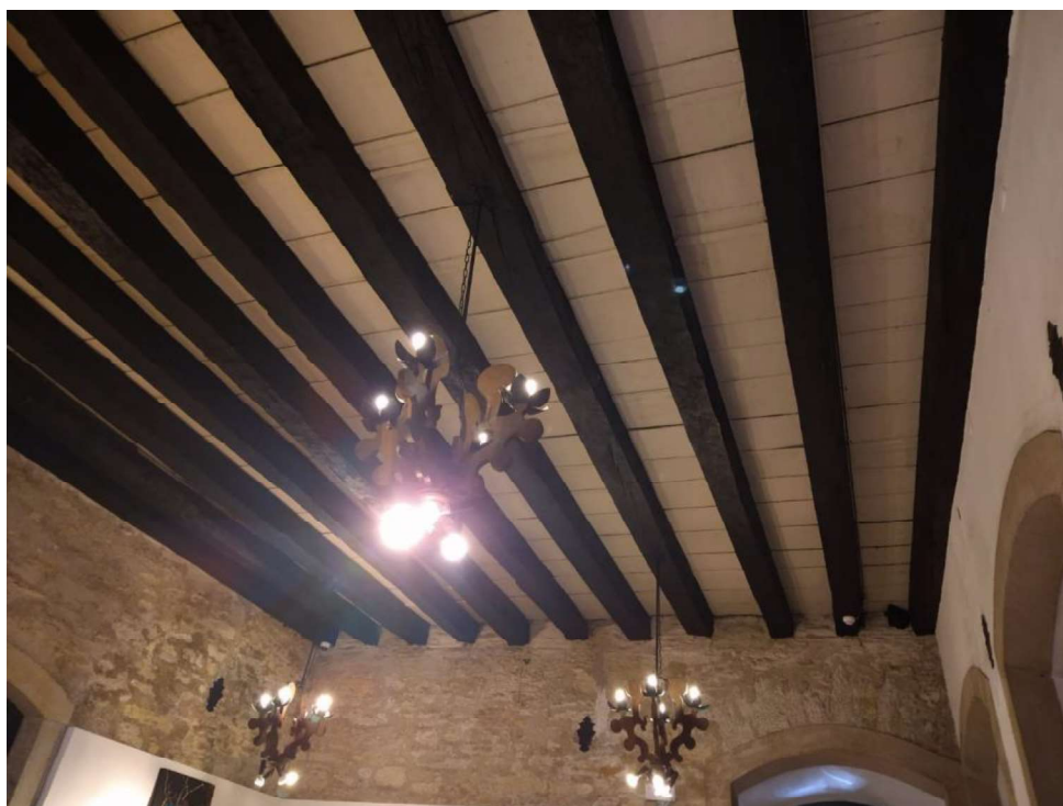
Figura 9 – Vigotas, pintadas na cor preta, contrastando com tábuas do piso, pintadas na cor branca. Casa dos Contos.
