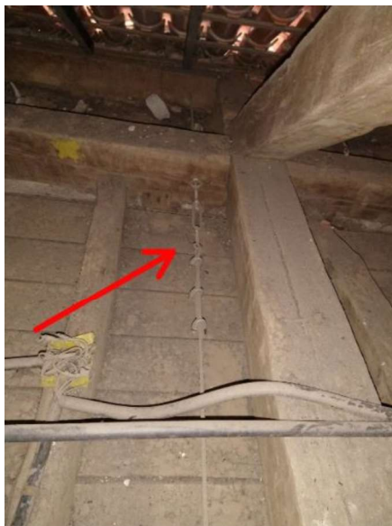
Figura 42 – Cabo de aço anexado nas extremidades da tesoura para impedir movimentação lateral da estrutura do telhado, e conseqüentemente das paredes.
