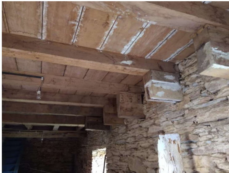
Figura 45 – Visão da parte inferior das lajes da casa.
