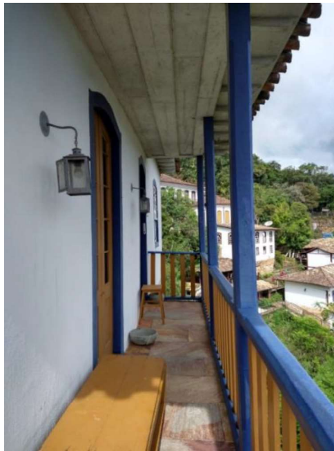
Figura 50 – Varanda da casa, construída em madeira com piso revestido com pedras.
