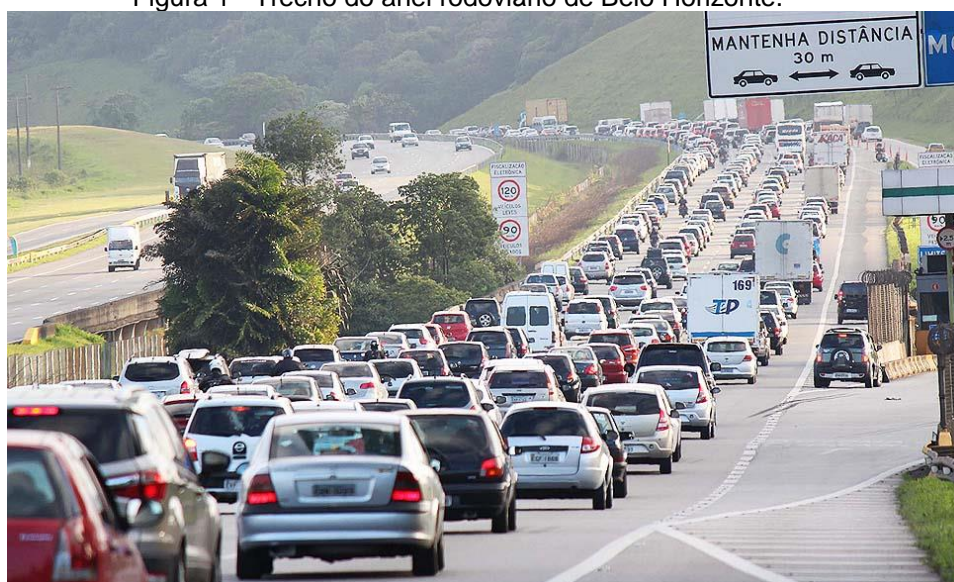
Figura 1 - Trecho do anel rodoviário de Belo Horizonte.
