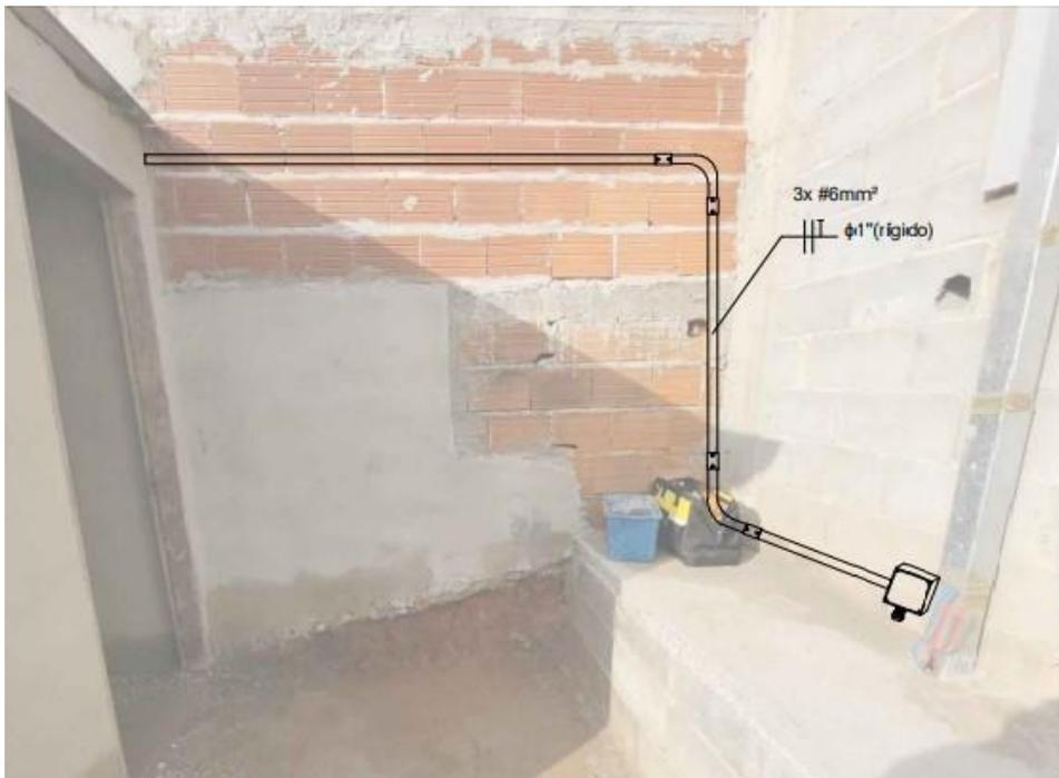
Figura 8: Caminho percorrido pelos cabos para chegada no ponto de energia
