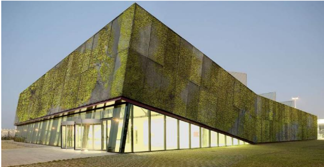
Figura 2 - Concreto bioreceptivo para criação de fachadas vegetais do Centro Cultural Aeronáutico de Sergi Godia, Berta Barrio, Eloi Juvillà.
