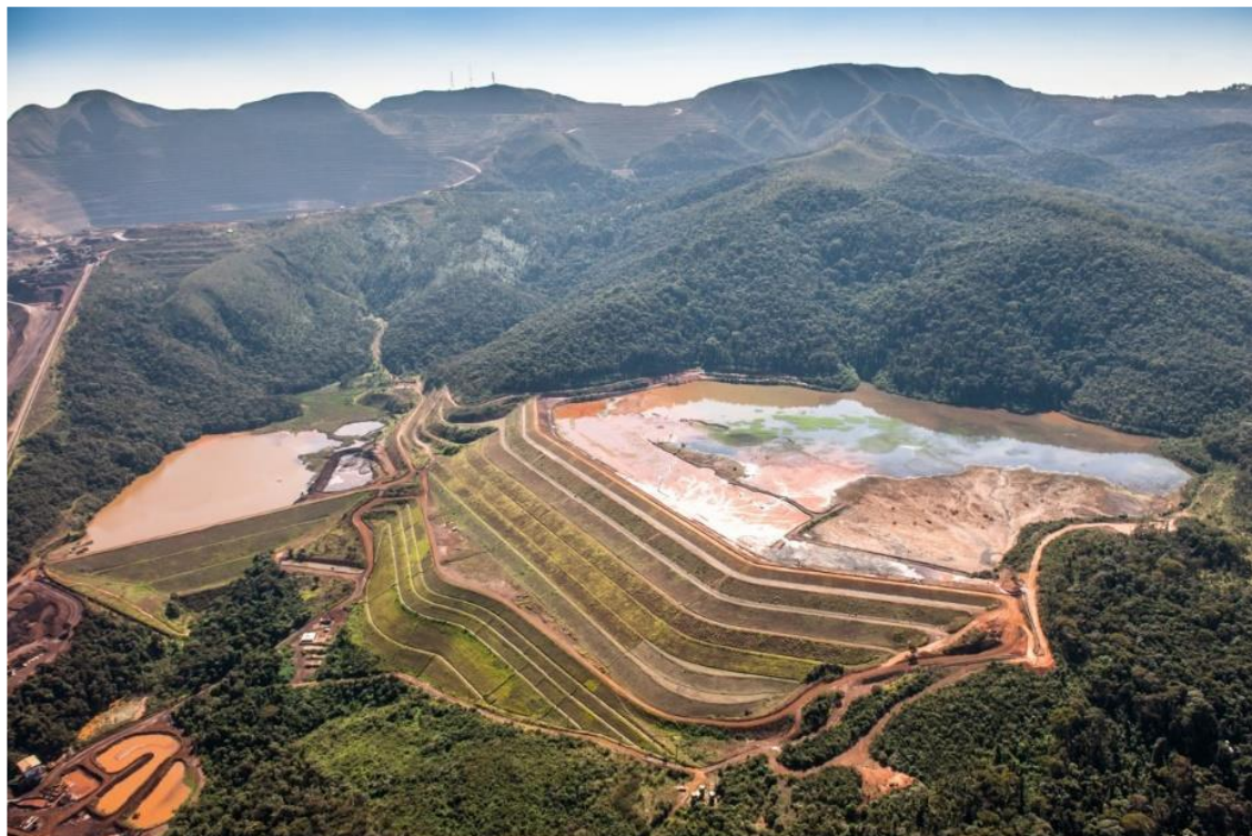
Figura 2 – Vista aérea da Barragem I -Mina Córrego do Feijão, Complexo Paraopeba - VALE S. A., Brumadinho/MG
