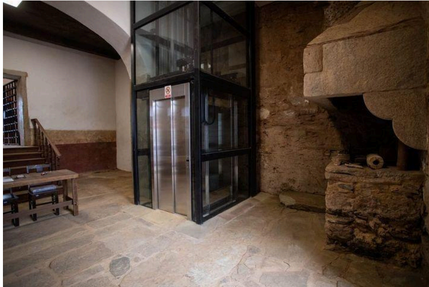
Imagem 2 - Elevador de Acessibilidade para Alcançar a Parte Superior do Edifício.
