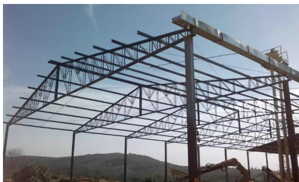
(a) Coberturas em treliças
