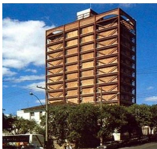
(b) Contraventamentos em V invertido
