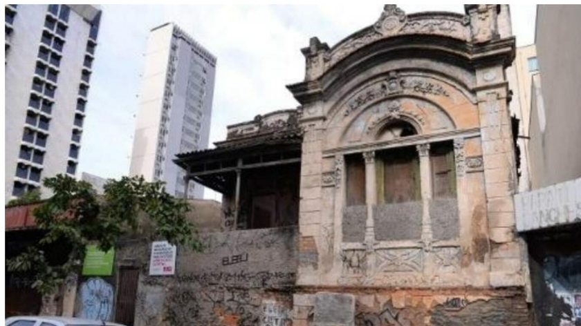
Figura 1- Prédio tombado em Belo Horizonte deve abrigar o Museu do Sexo das Putas
