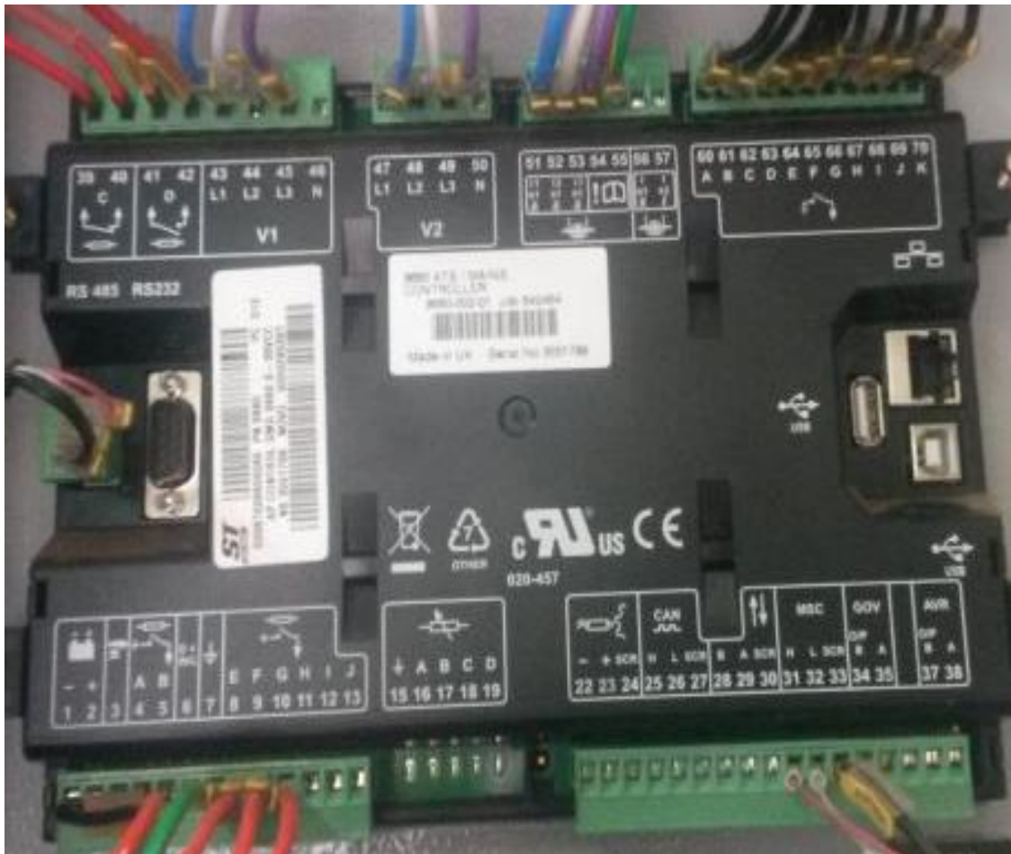
Figura 5.10: Ligações realizadas no controlador DSE8660
