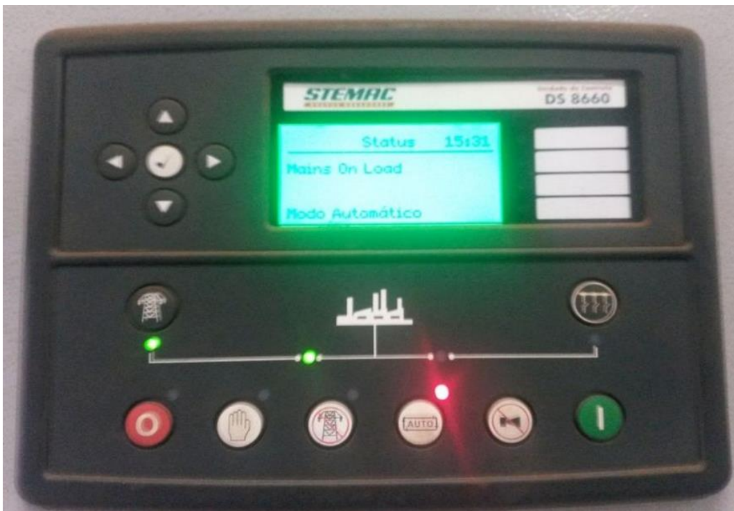
Figura 5.111: Sinalizações indicando o funcionamento do módulo de controle DSE8660
