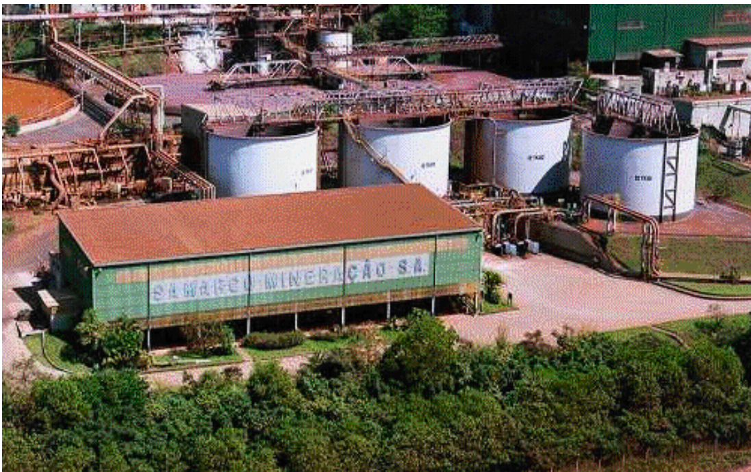
Figura 2.3: Estação de bombeamento Samarco.
