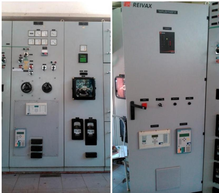
Figura 30 - Painel de controle PC02 antigo à esquerda e PC02 novo à direita. Fonte: o autor.
