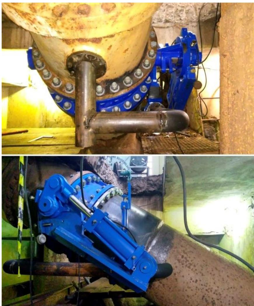
Figura 28 - Acima visão da válvula borboleta nova instalada e adaptações para a válvula by-pass abaixo cilindro de atuação na válvula borboleta e flange de adaptação soldado. Fonte: o autor.
