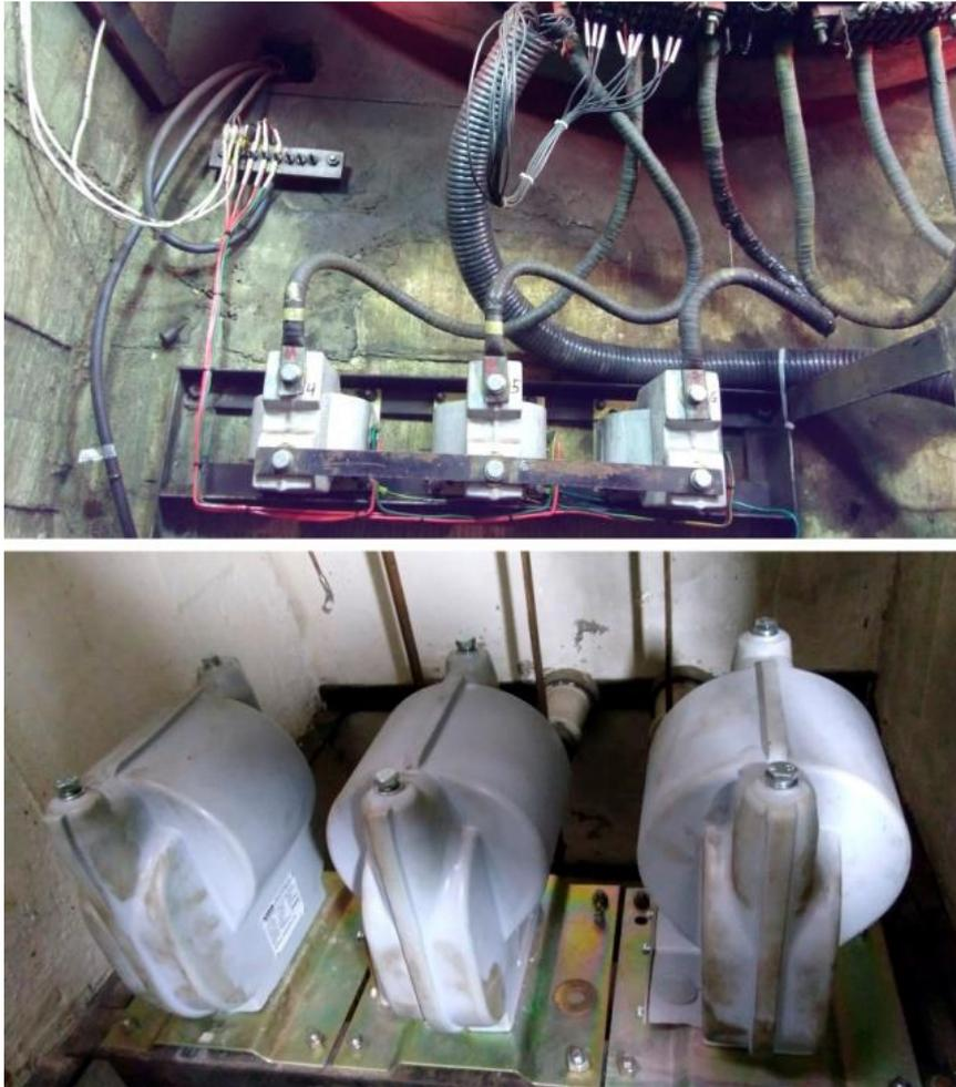
Figura 29 - TC's e TP's de proteção e medição novos instalados. Fonte: o autor.
