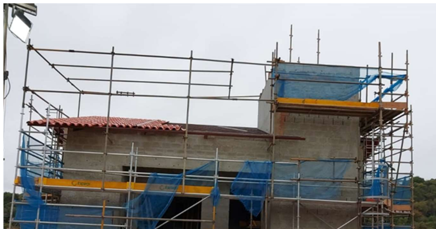
Figura 32- Telhamento em execução na edificação estudada.
