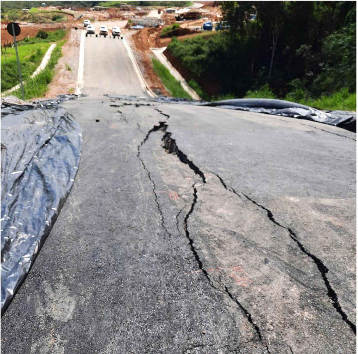
Figura 17 - Trincas na via.
