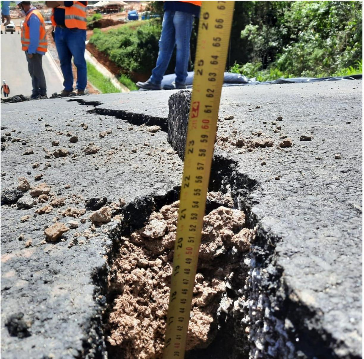
Figura 15 - Profundidade da trinca na via.
