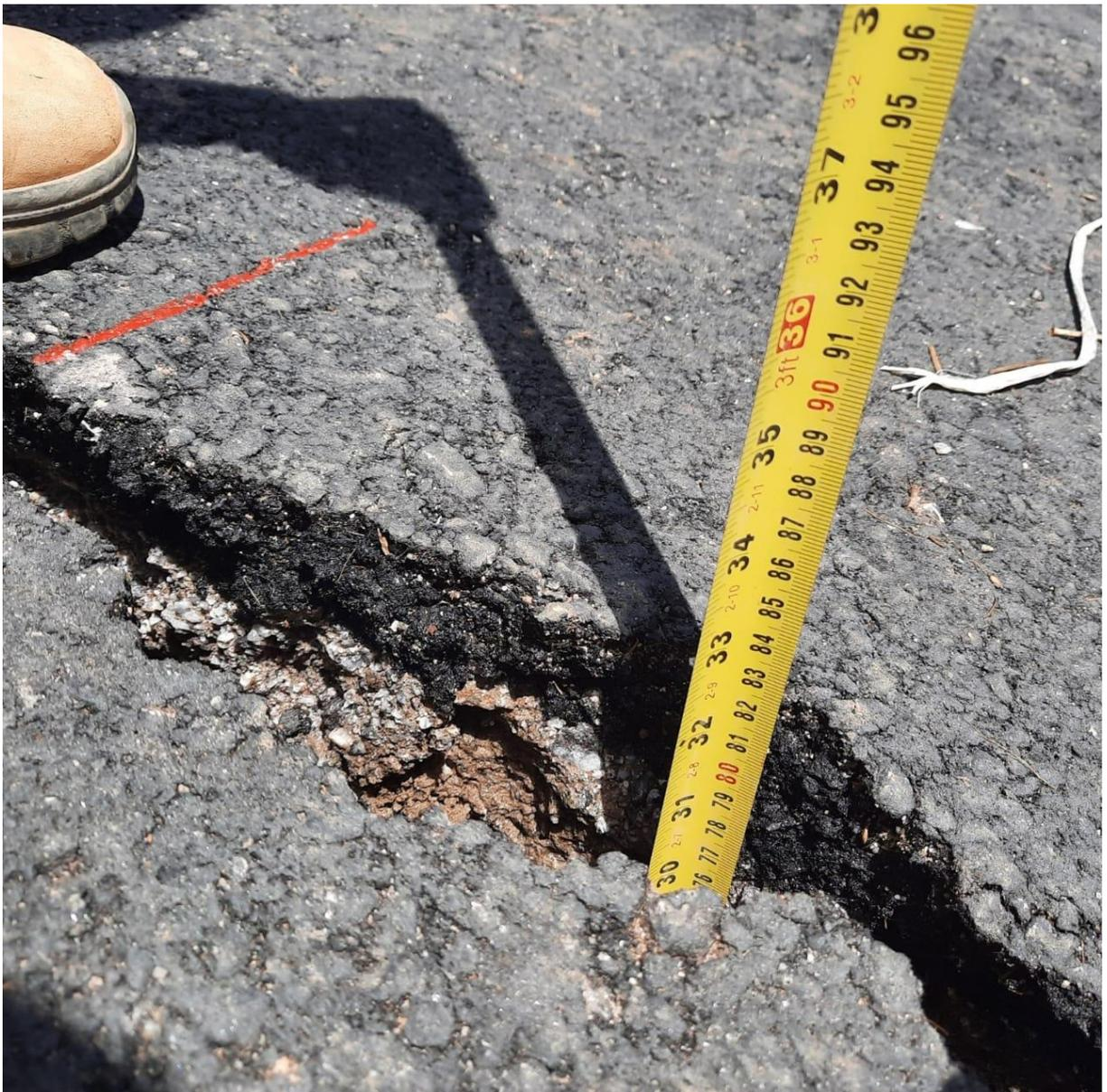
Figura 13 - Profundidade da trinca na via.
