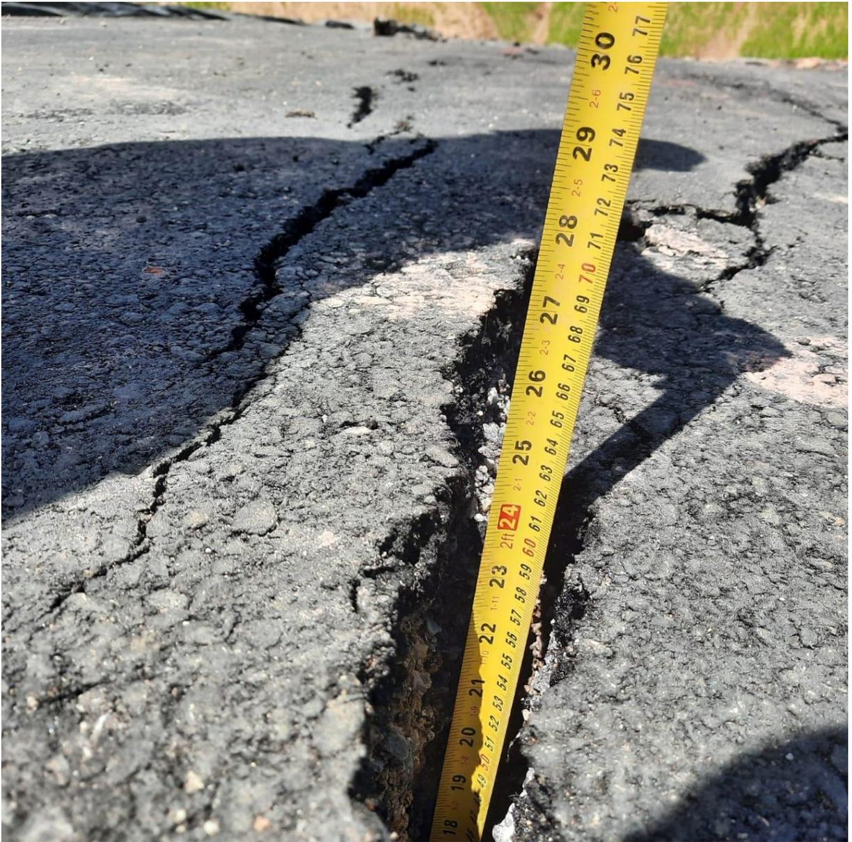
Figura 16 - Profundidade da trinca na via.
