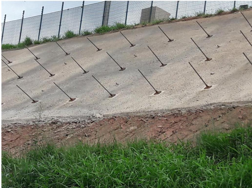
**Figura 4** – Exemplo de estrutura com ancoragem. Fonte: Grupo Torcisão, 2017.
