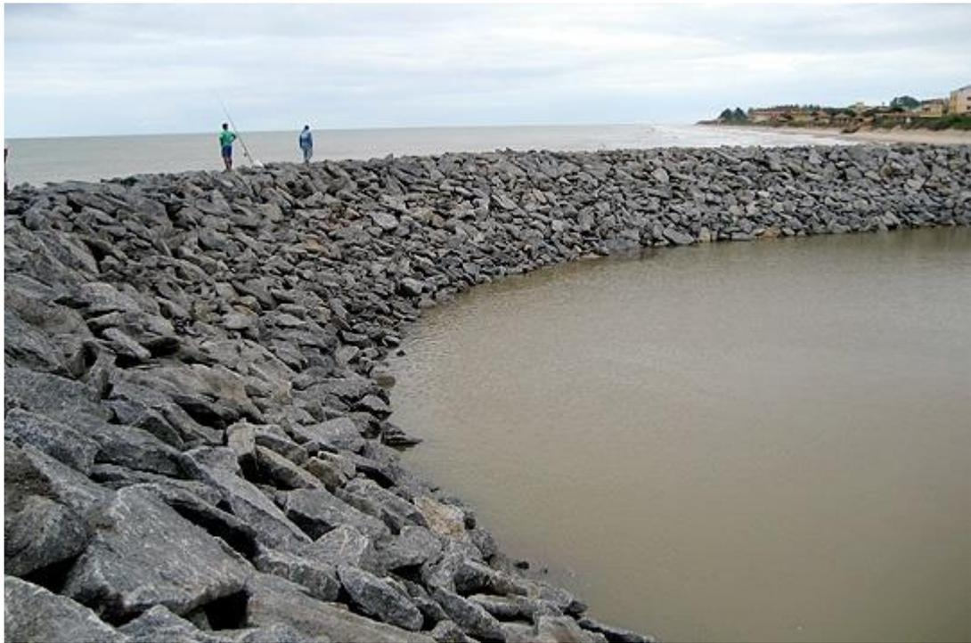
**Figura 3** – Exemplo de estrutura de enrocamento. Fonte: EngWhere, 2023.
