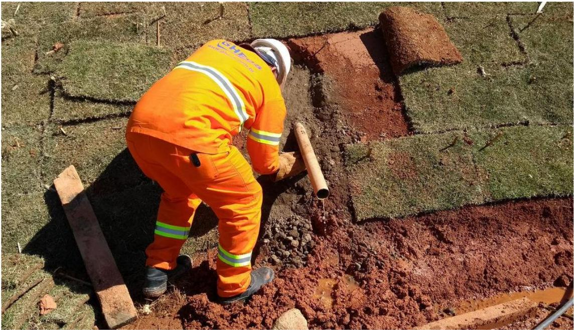
**Figura 5** – DHP instalado na encosta. Fonte: GHEOS, 2023.
