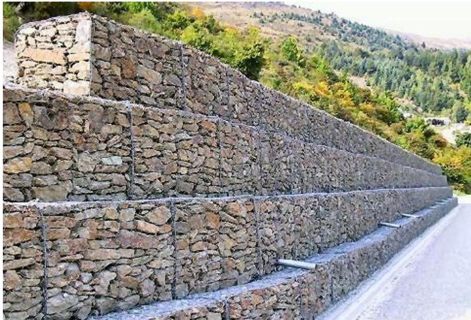
**Figura 2** – Exemplo de uma estrutura de gabião. Fonte: Awa Comercial, 2023.
