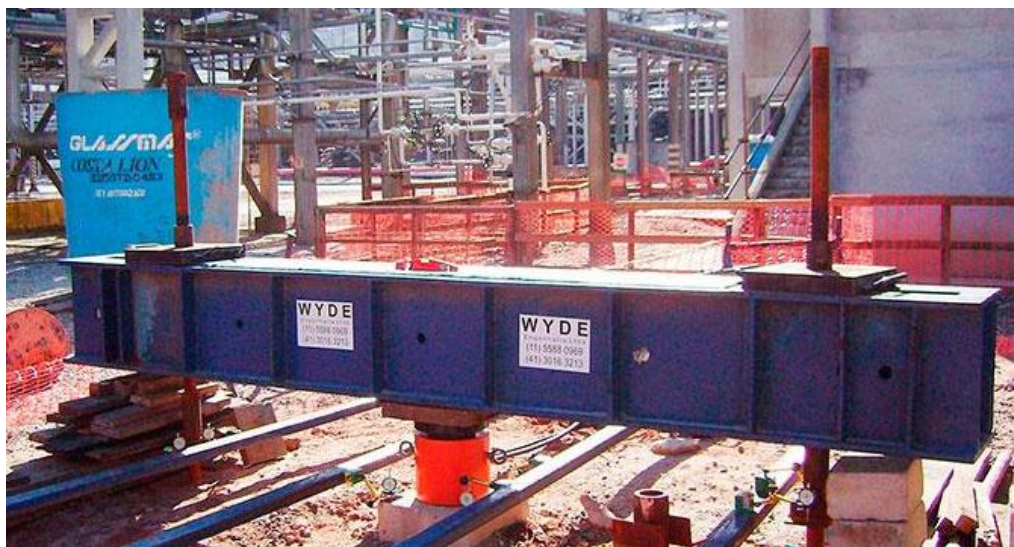
Figura 7-Ensaio de Prova de Carga.
