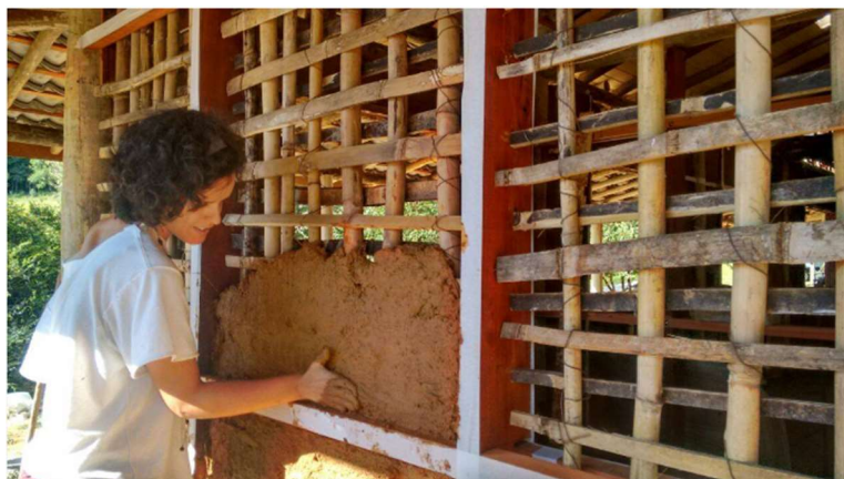
Figura 5 - Preenchimento de paredes de pau a pique com a mistura de barro, água e fibra.
