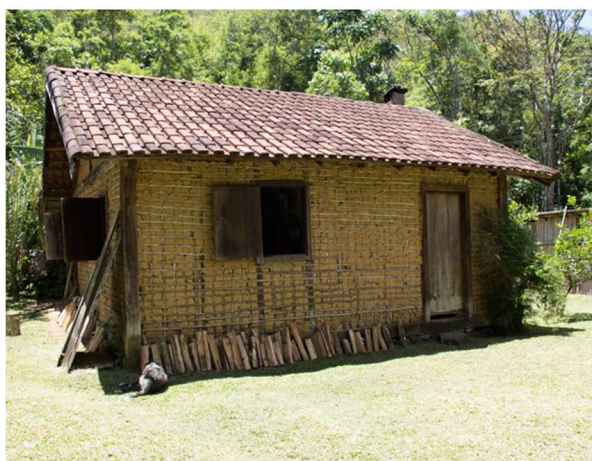
Figura 8 - Telhado com telhas coloniais.
