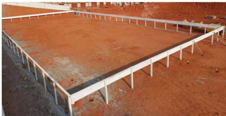
Figura 2 - Gabarito de obras
