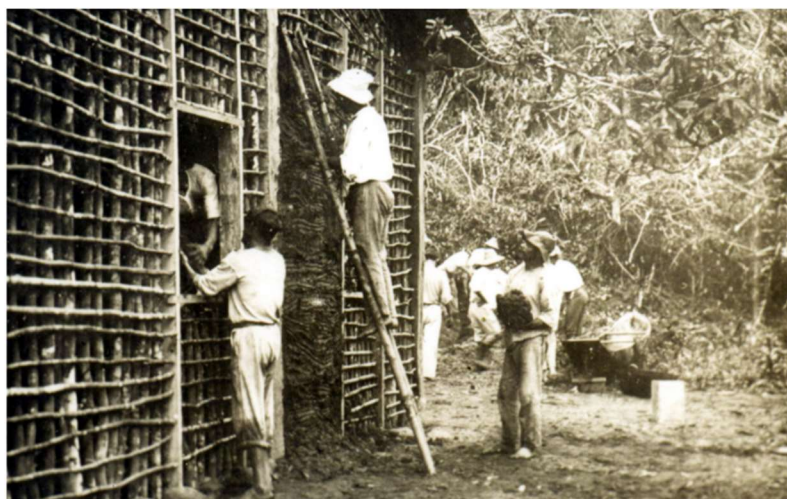
Figura 4 - Trama de uma casa de pau a pique.
