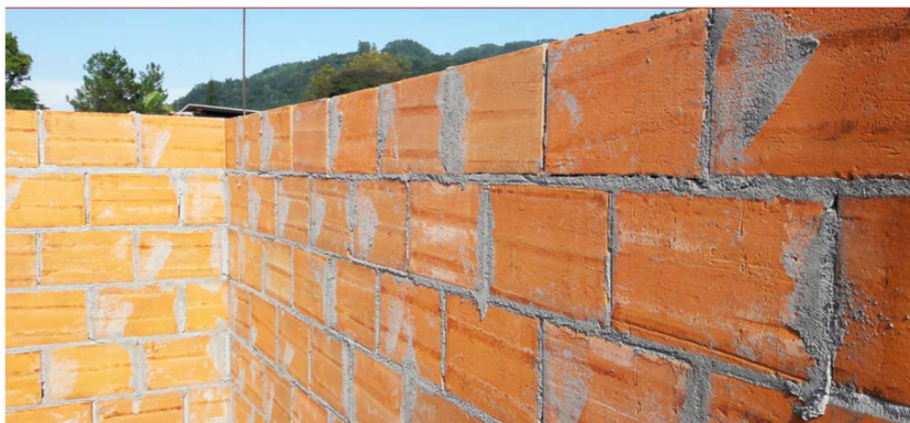
Figura 3 - Assentamento de blocos cerâmicos em edificação de alvenaria estrutural.
