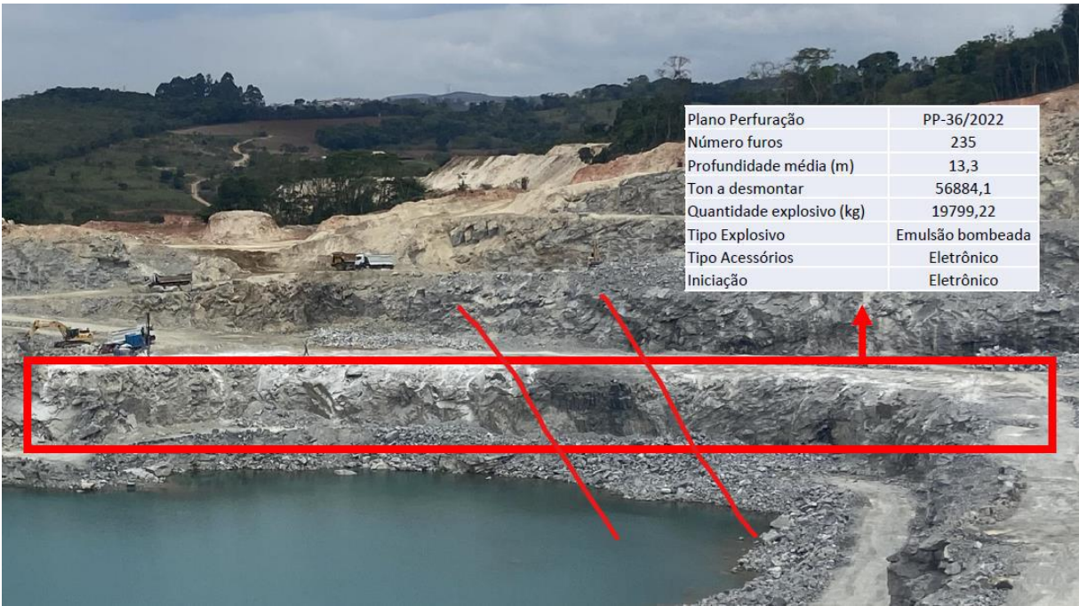
Figura 16 - Dique máfico vista frontal
