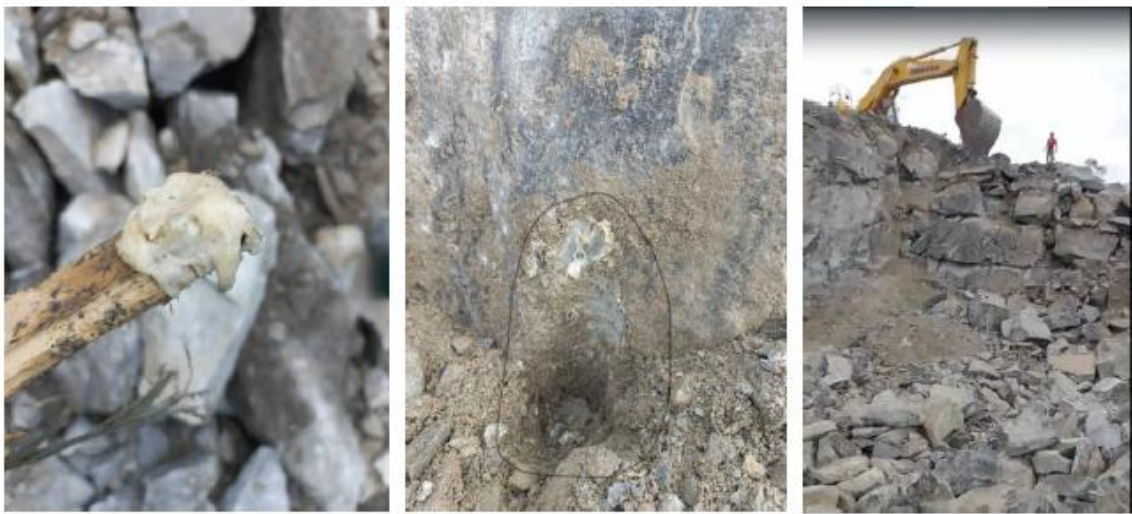
Figura 13 - Escavação da zona de fragmentação inadequada mostrando resquícios de emulsão não detonada
