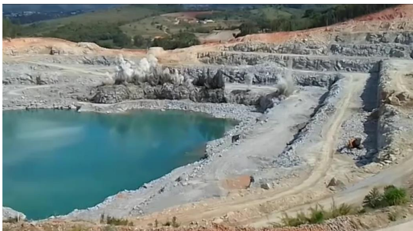
Figura 9 - Desmonte da primeira linha da bancada (furos 34 a 24)
