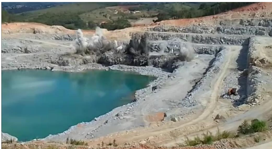
Figura 11 - Desmonte da primeira linha da bancada (furos 24 a 01)
