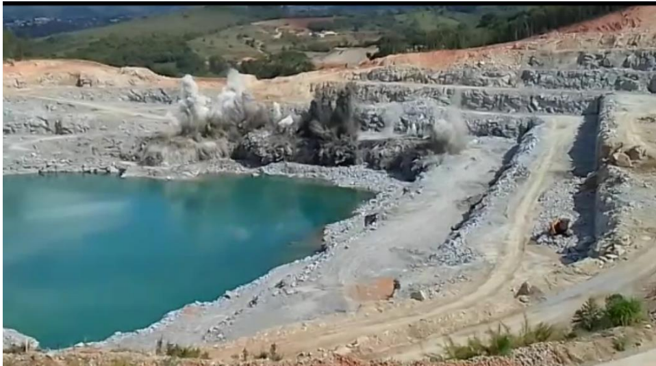
Figura 10 - Furos de trás escapando gases por áreas de menor resistência
