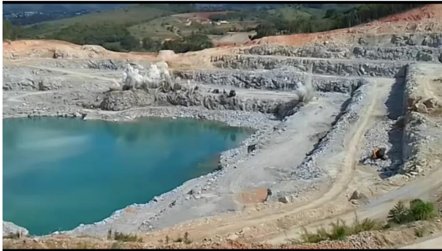
Figura 8 - Desmonte da primeira linha da bancada (furos 34 a 50)
