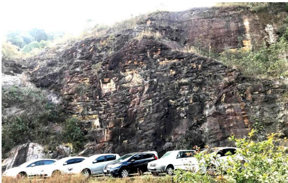
Figura 15 – Talude CB localizado nas dependências do 5º Pelotão de Bombeiros Militar de Minas Gerais, 2ª Companhia de Ouro Preto.
