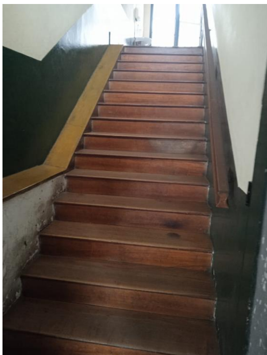
Figura 47 – Acesso ao pavimento superior – portaria 3
