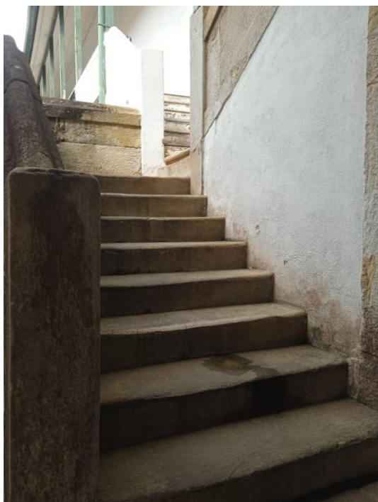
Figura 44 – Conjunto de escadarias que levam ao pavimento superior
