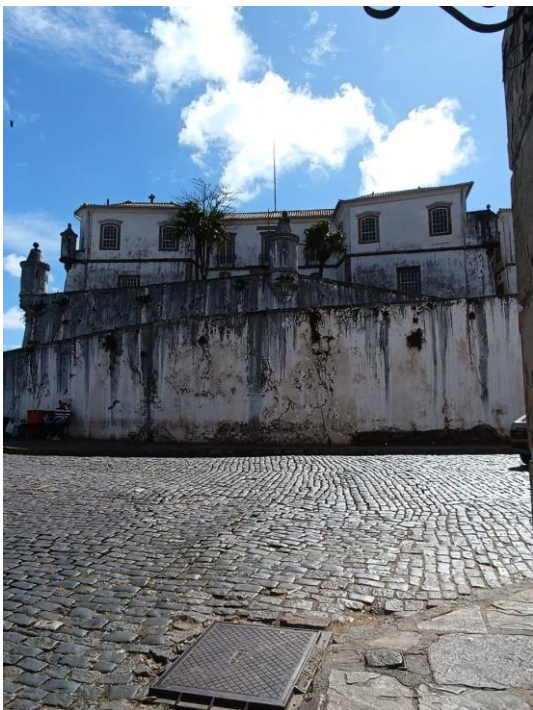
Figura 71 – Fachada principal da Escola de Minas
