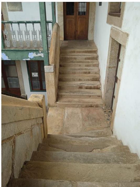
Figura 43 – Vãos de escada para o pavimento superior
