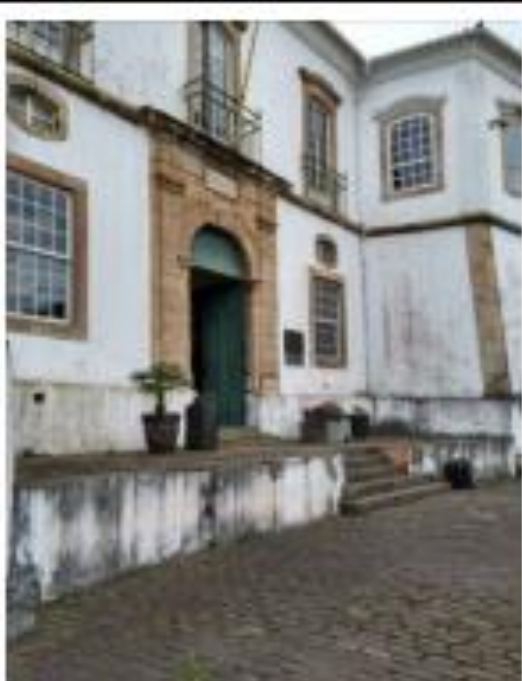
Figura 25 – Portão de acesso ao pavimento inferior
