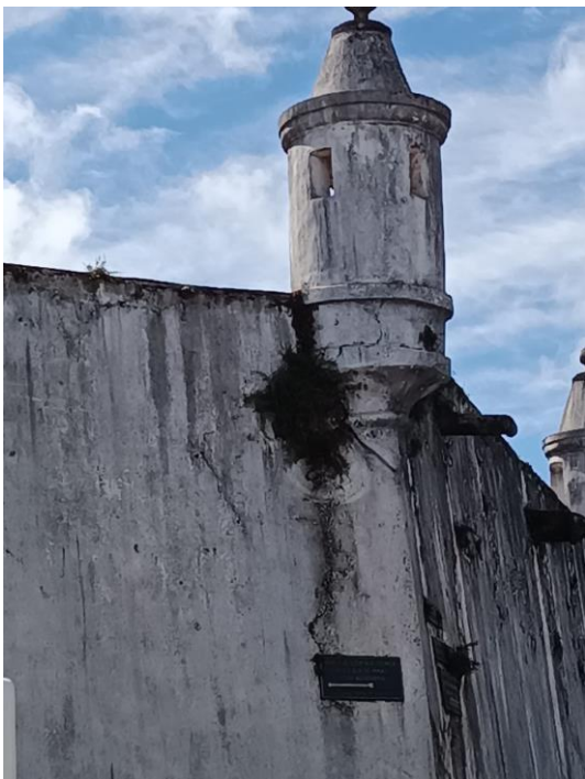
Figura 51 – Lodo, líquen, mancha de umidade e hera em uma das fortificações de sentinela
