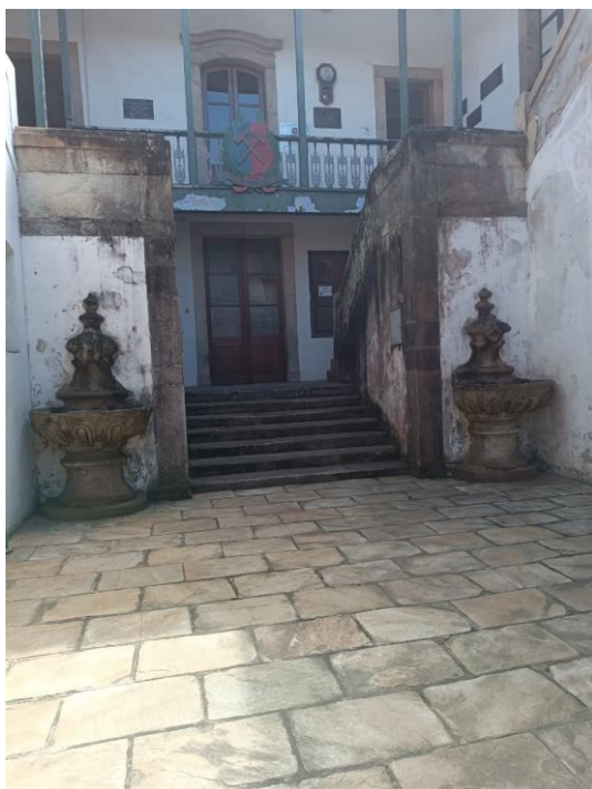
Figura 65 – Escadarias, paredes, chafarizes e cantaria contaminada com líquens no pátio interno principal
