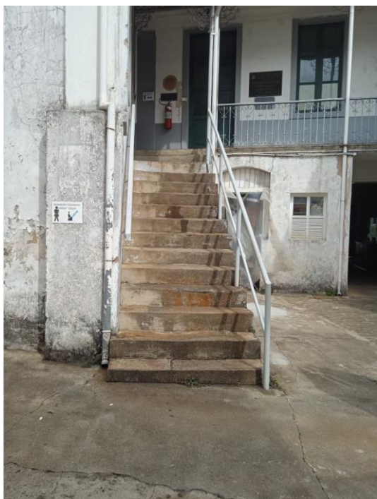
Figura 46 – Acesso para o pavimento superior via portaria 2
