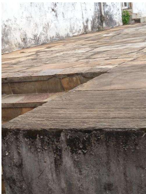
Figura 33 – Acesso para a escadaria da capela
