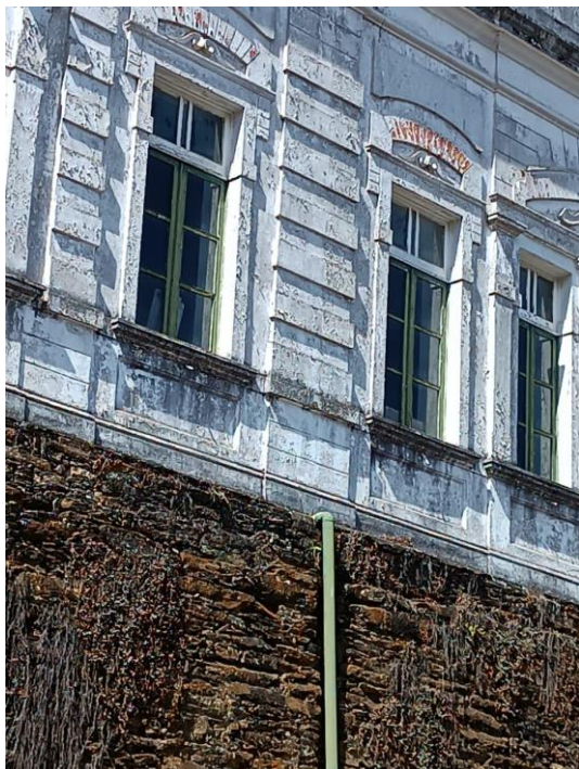
Figura 58 – Detalhe de fachada lateral
