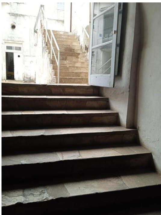
Figura 37 – Conjunto de degraus na cantina – pátio 2 para pátio 1
