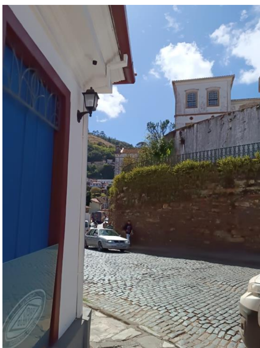
Figura 56 – Canteiro de heras em fachada em direção à Rua Conselheiro Quintiliano (Praça Tiradentes)
