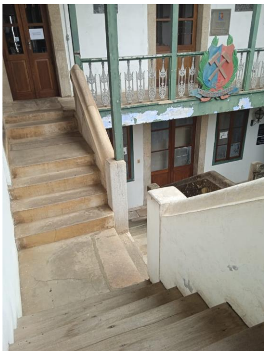
Figura 45 – Escadarias do pavimento superior
