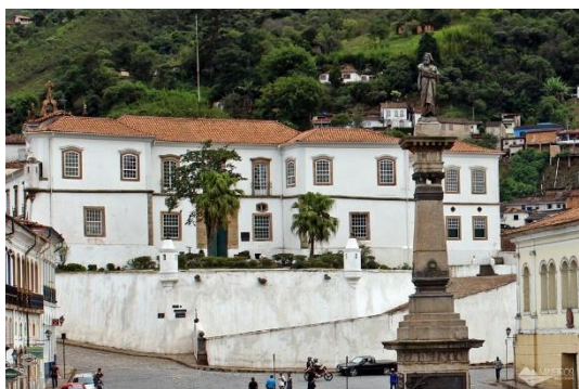
Figura 24 – Rampa de acesso
