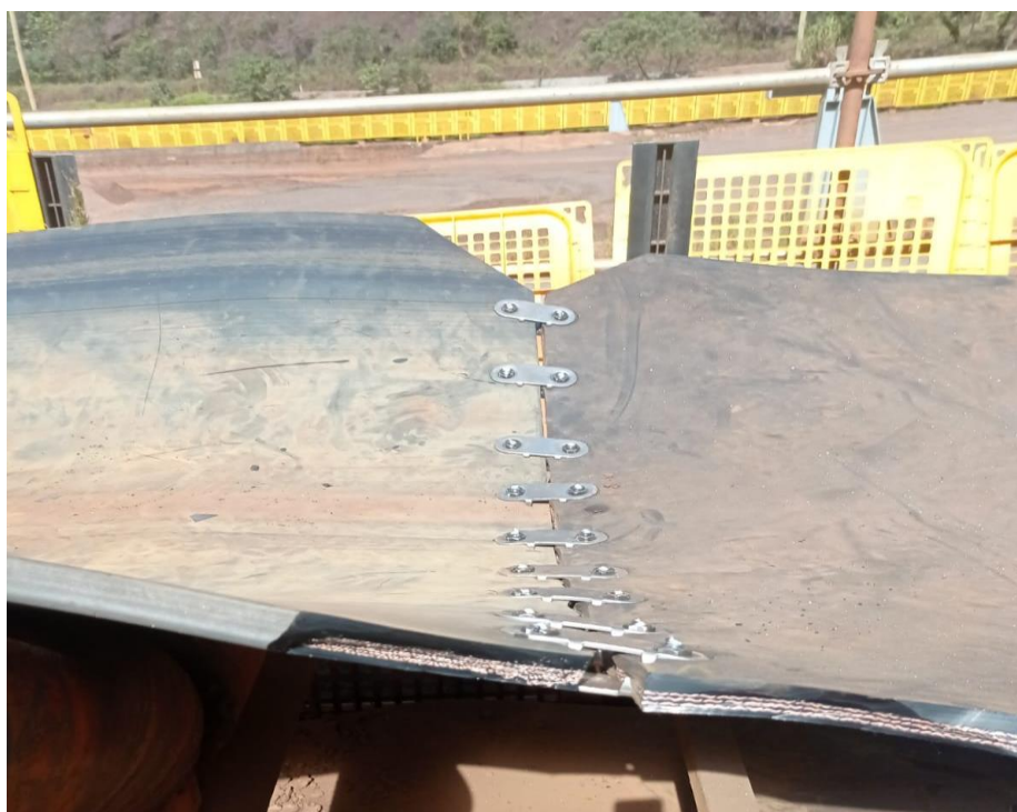
Figura 17 – Grampeamento da correia nova com a desgastada. Fonte: Pesquisa direta (2023)
