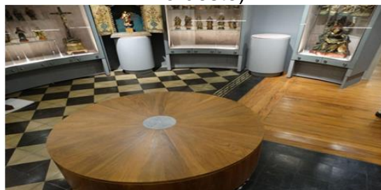
Figura 127 - Integração entre o piso hidráulico e o piso em madeira (Sala Brasil Nordeste)
