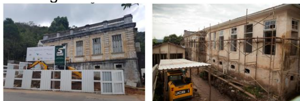
Figuras 17 e 18 - Início das obras
