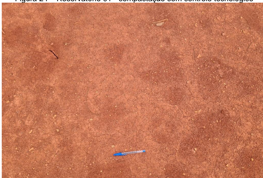
Figura 24 – Reservatório 01 - compactação com controle tecnológico
