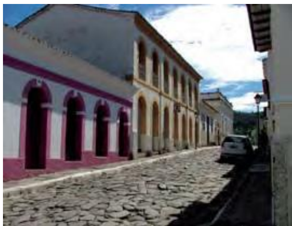
Figura 2: Calçamento irregular em pedra, Goiás/GO, 2013. Fonte: RIBEIRO, S. (2014)
