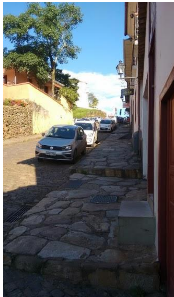
Figura 21: Declividade significativa na Rua das Flores, exigindo pequenas escadas ou rampas para o acesso às casas. Fonte: Acervo da autora (2018)
