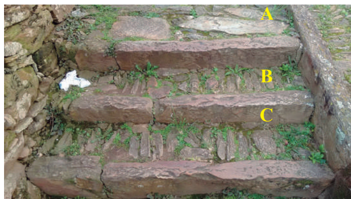
Figura 3: Destaque para a pavimentação do patamar (A), dos pisos (B) e dos espelhos (C).
