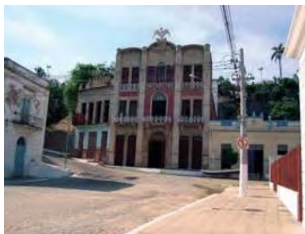
Figura 3: Calçadas e edifícios sem acessibilidade, Corumbá/MS, 2010. Fonte: RIBEIRO, S. (2014)
