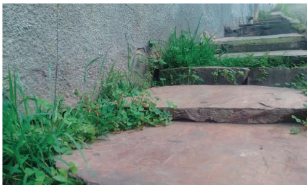
Figura 16: Vegetação ao longo de toda a escadaria.
