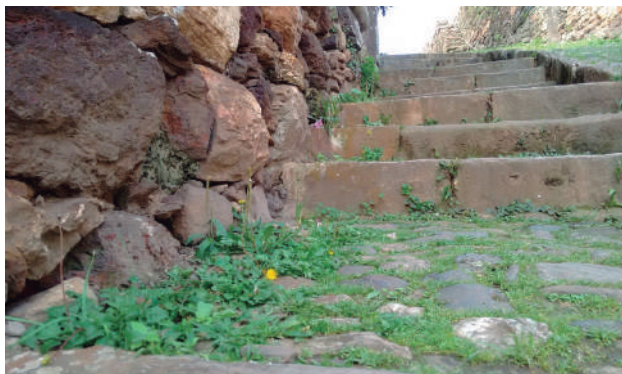
Figura 14: Vegetação ao longo de toda a escadaria.
