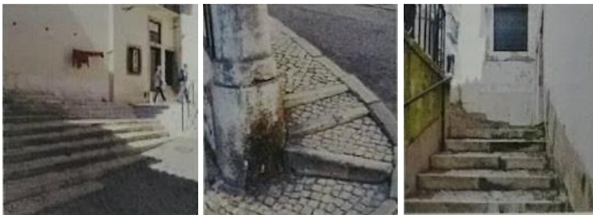
Figura 18: Calçada da Figueirinha e Rua Castelo Picão, passeio em degraus na Travessa de São Tomé e passeio em patamares no Beco da Cardoso, respectivamente.
