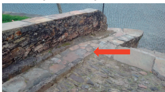
Figura 8: Destaque para a canaleta elaborada com pedras ouro preto em paralelepípedo.
