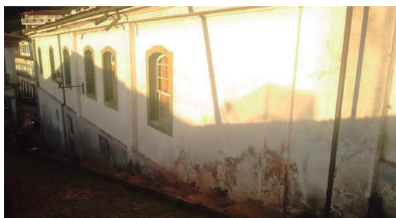
Figura 7: Ausência de corrimão.
