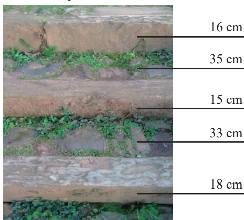
Figura 4: Destaque para as dimensões de pisos e espelhos.
