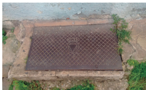
Figura 8: Poços de visita e inspeção.
