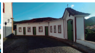
B Edificação civil na Rua Getúlio Vargas, 91.
