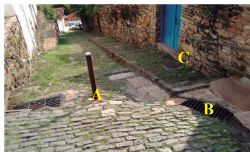
Figura 8: Balizador (A), grelhas (B) e poços de visita e inspeção (C).
