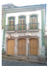
C Edificação civil na Rua Conde de Bobadela, 189.
