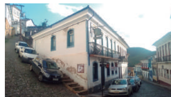
B Edificação civil na Rua Paraná, 20.
